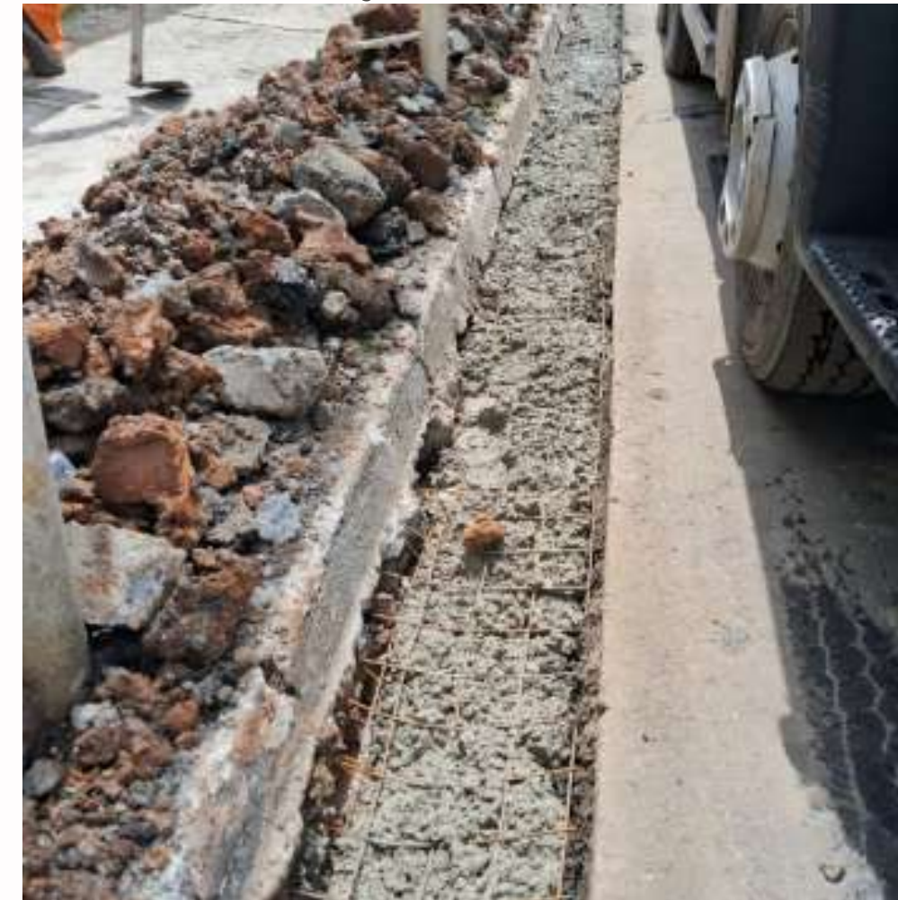
FOTO EM EXECUÇÃO:
