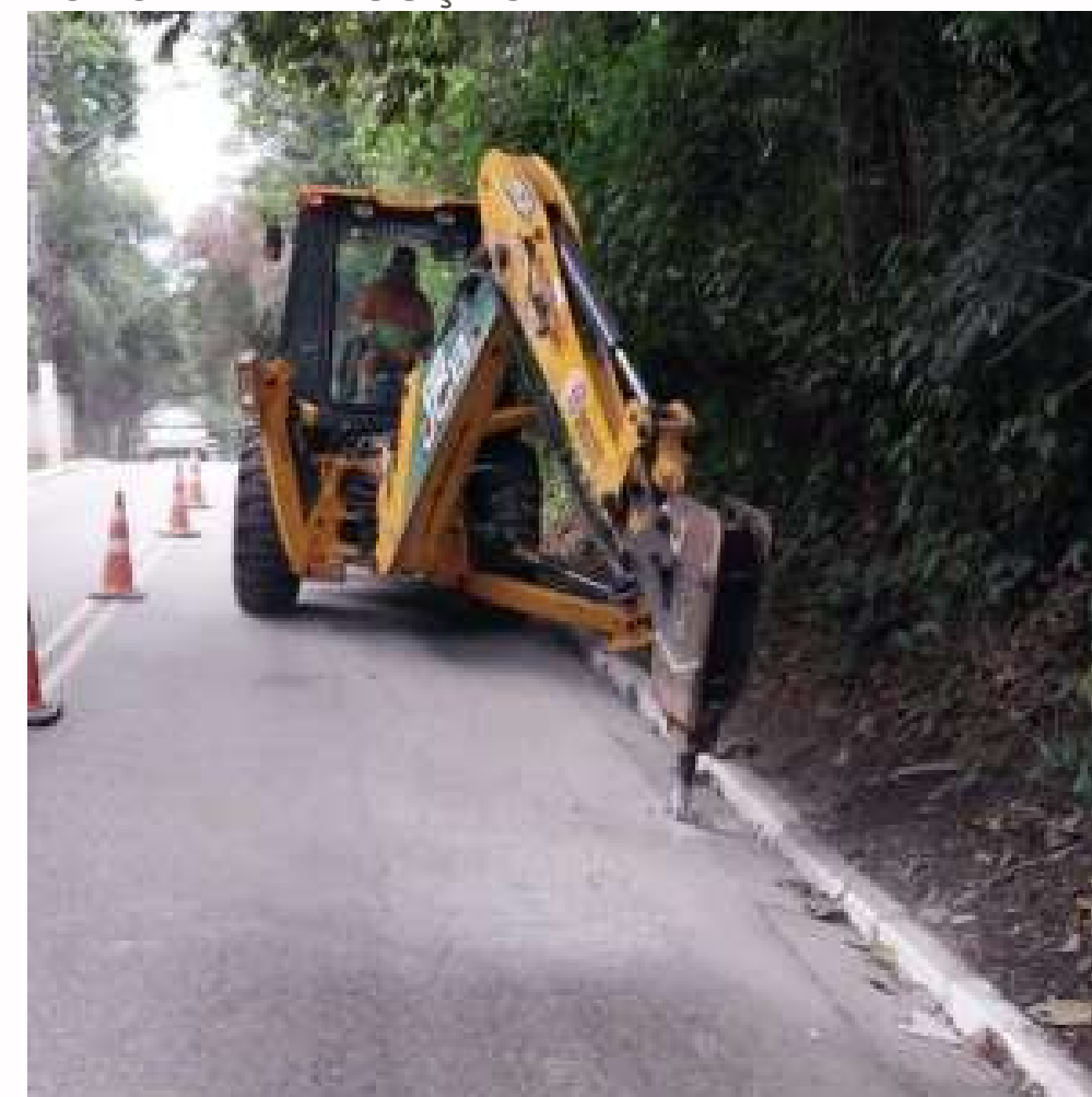
FOTO EM EXECUÇÃO:
