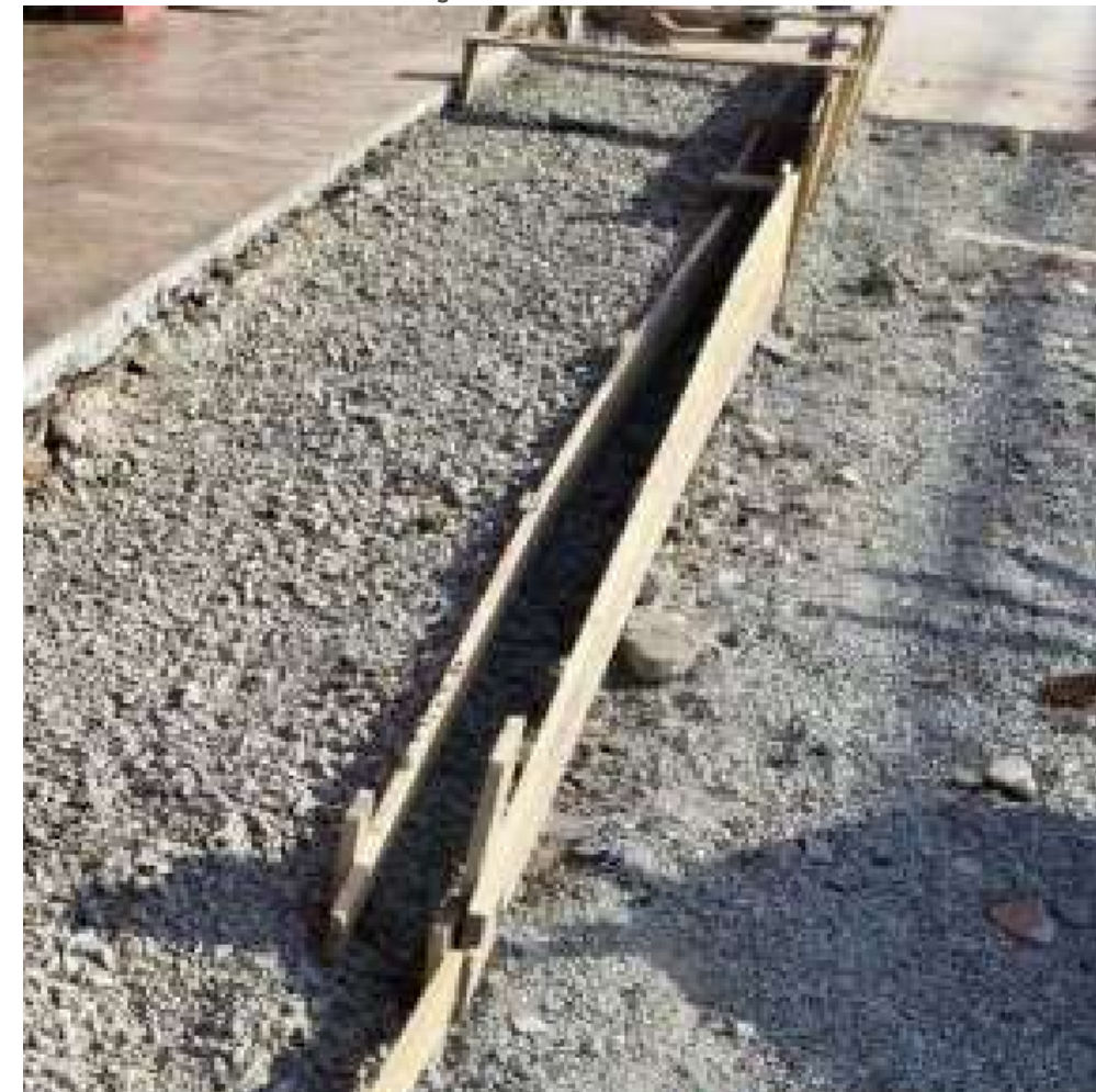
FOTO EM EXECUÇÃO:
