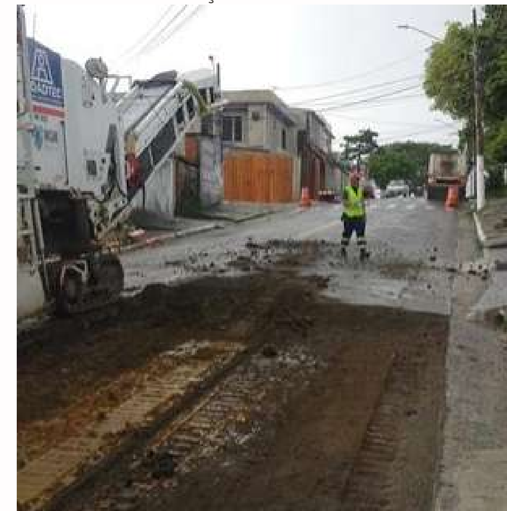
FOTO EM EXECUÇÃO:
