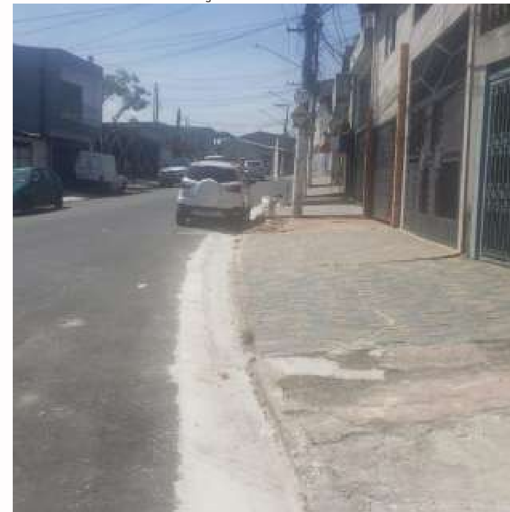
FOTO EM EXECUÇÃO:
