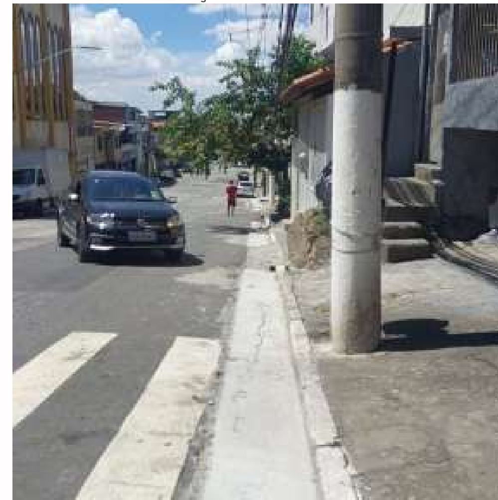
FOTO EM EXECUÇÃO:
