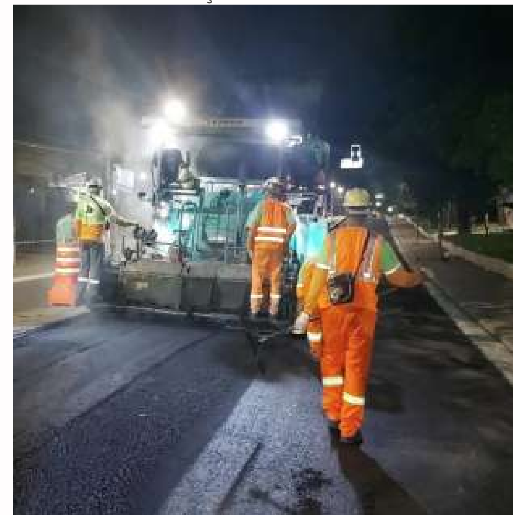
FOTO EM EXECUÇÃO:
