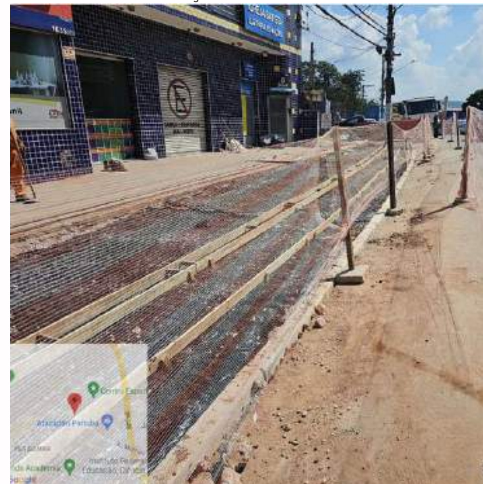
FOTO EM EXECUÇÃO:
