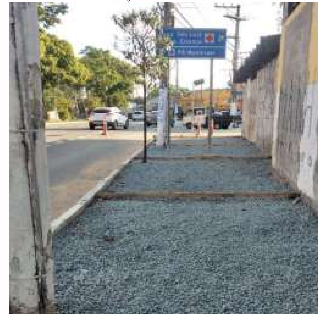
FOTO EM EXECUÇÃO:
