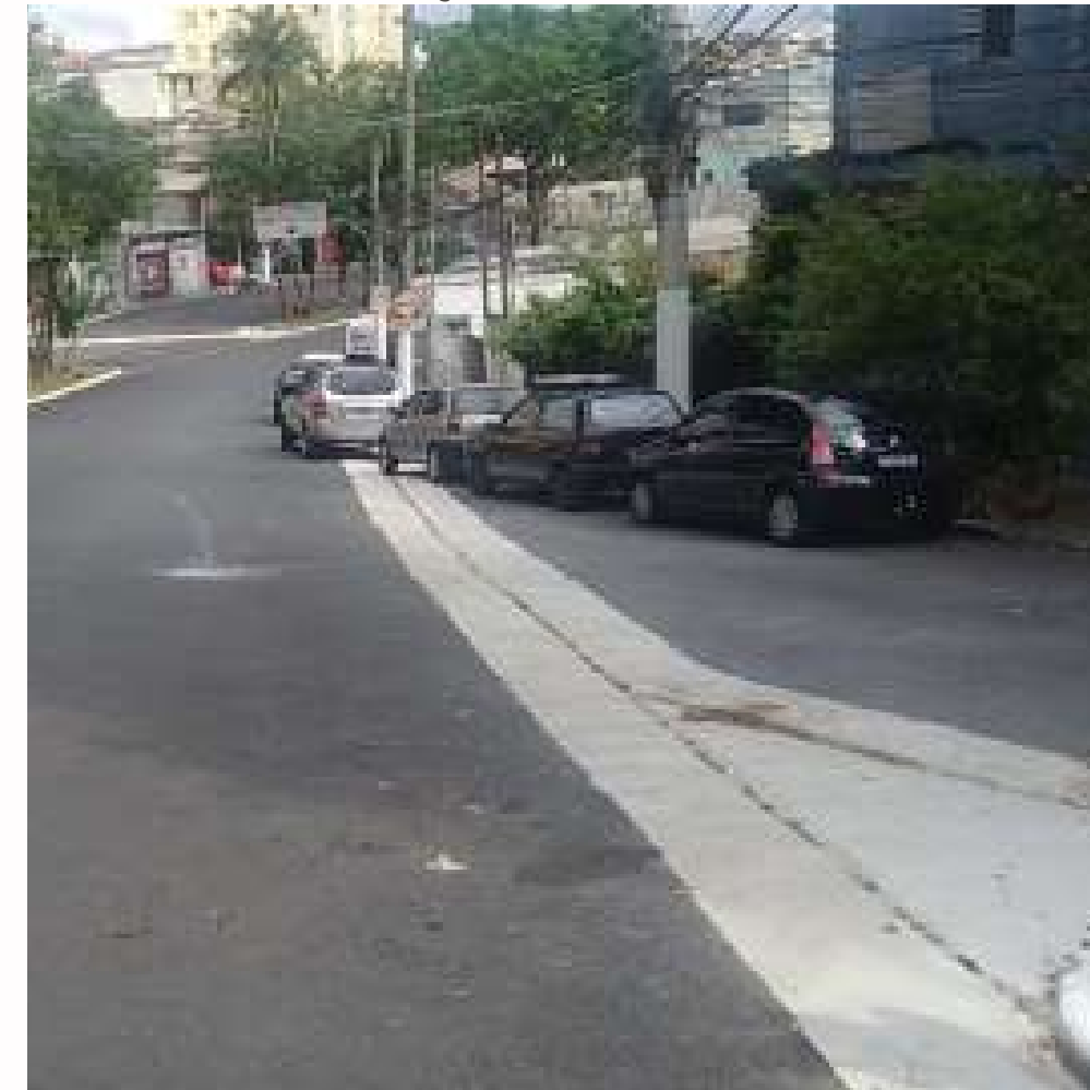
FOTO EM EXECUÇÃO:
