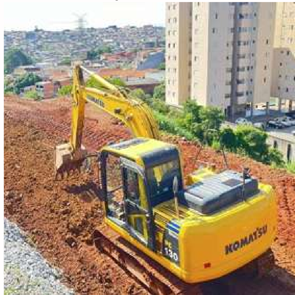
FOTO EM EXECUÇÃO:
