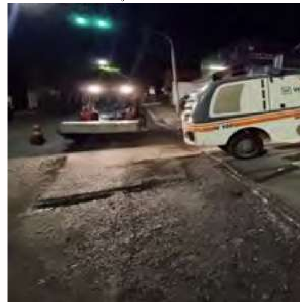
FOTO EM EXECUÇÃO:
