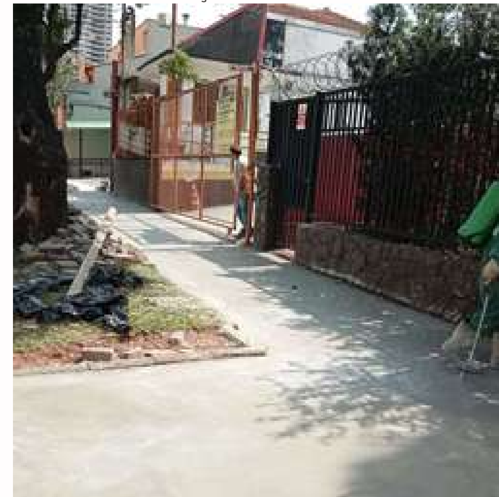
FOTO EM EXECUÇÃO:
