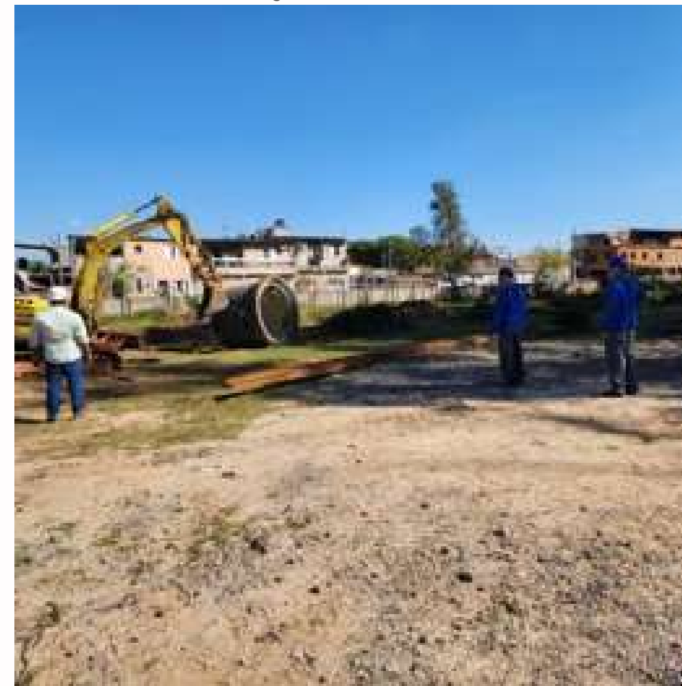
FOTO EM EXECUÇÃO:
