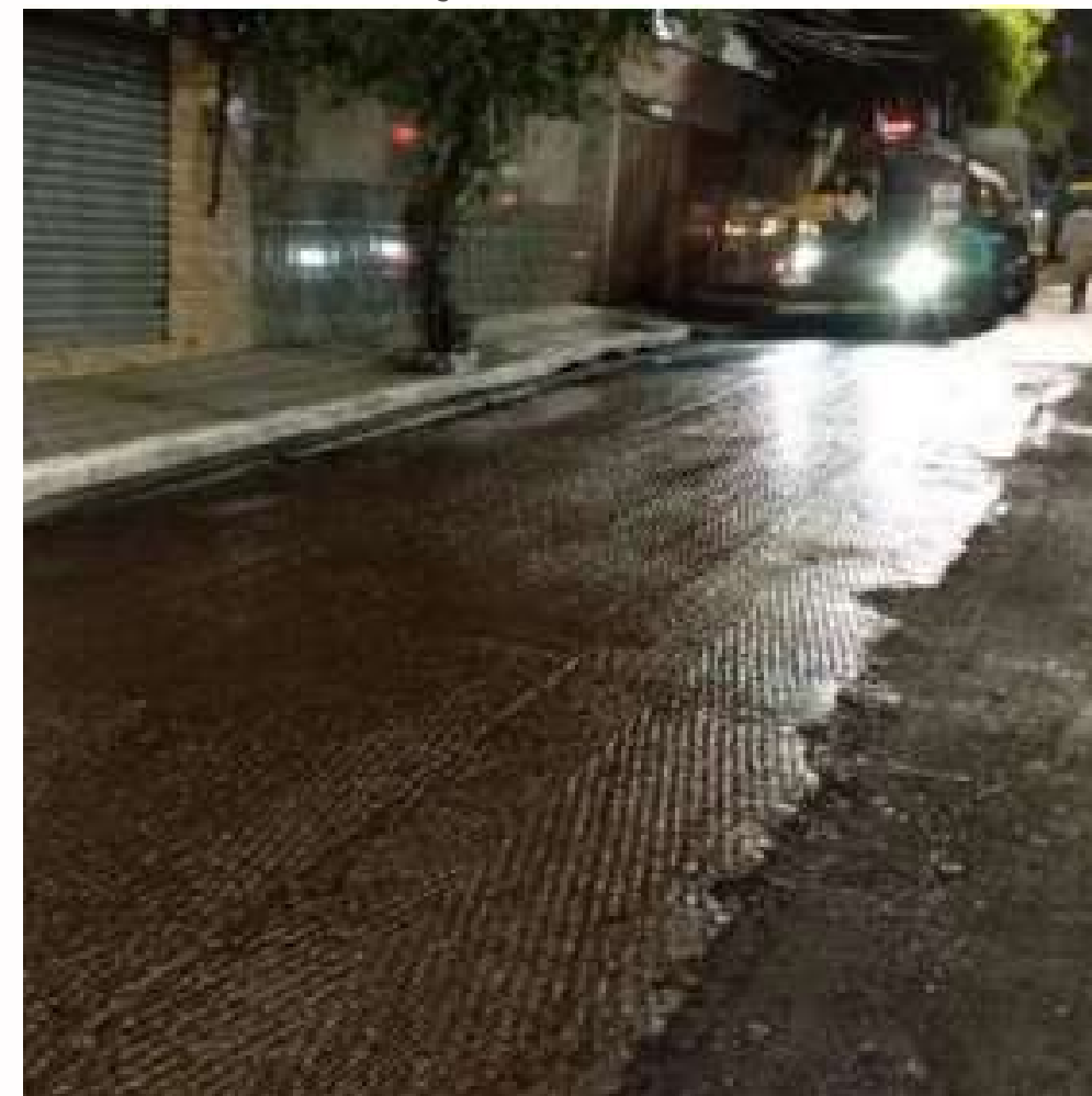
FOTO EM EXECUÇÃO:
