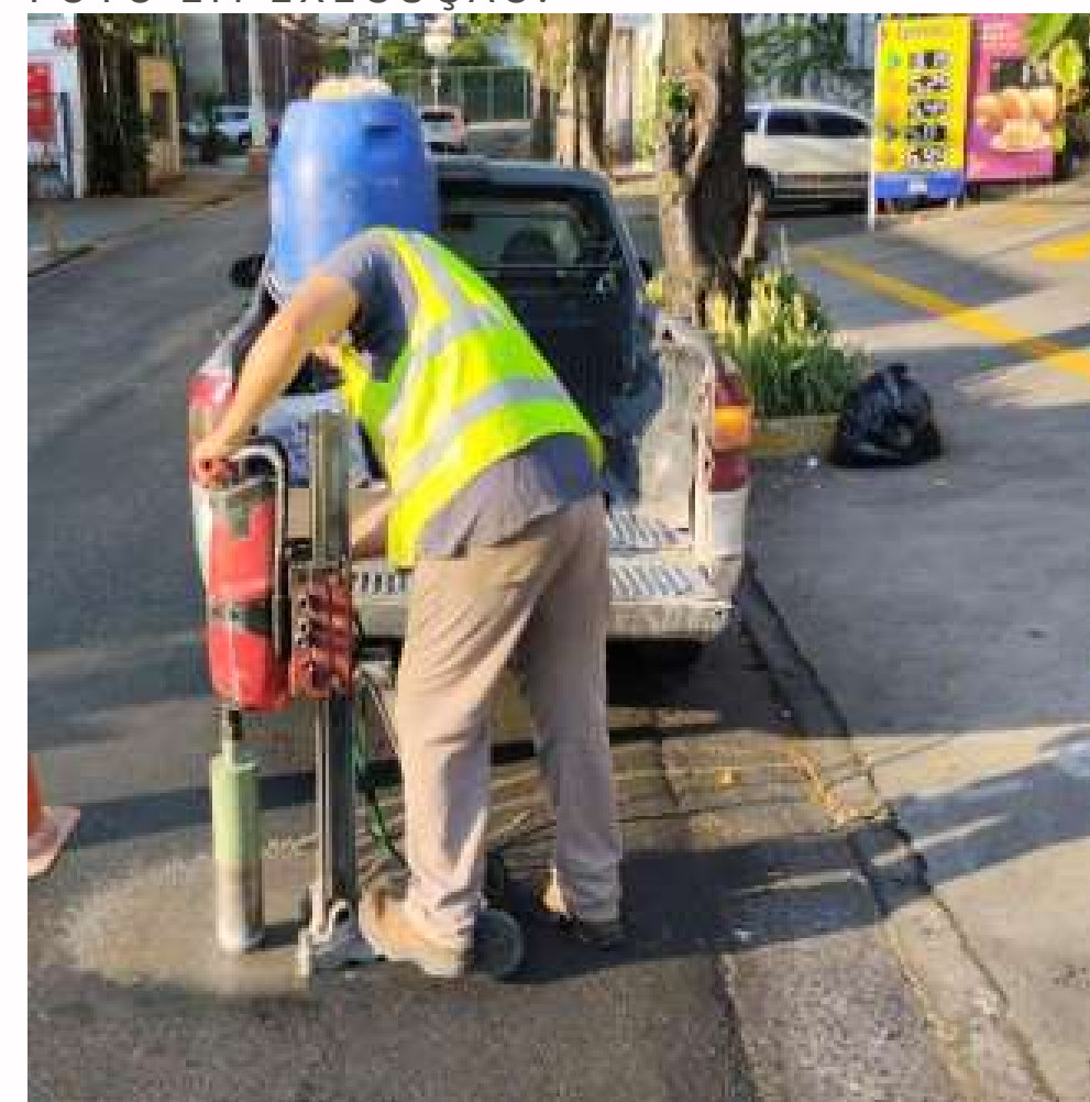
FOTO EM EXECUÇÃO:
