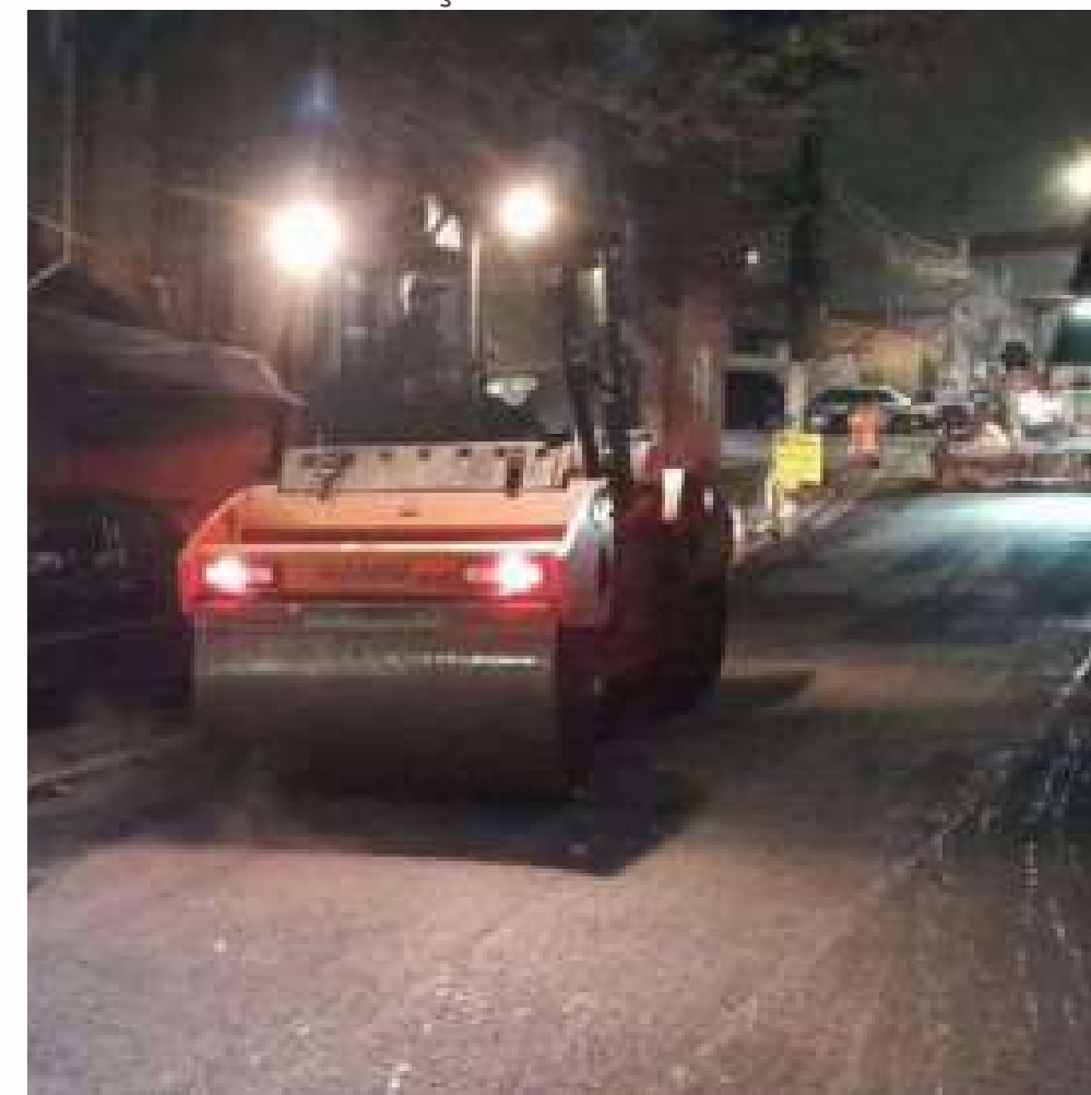
FOTO EM EXECUÇÃO:
