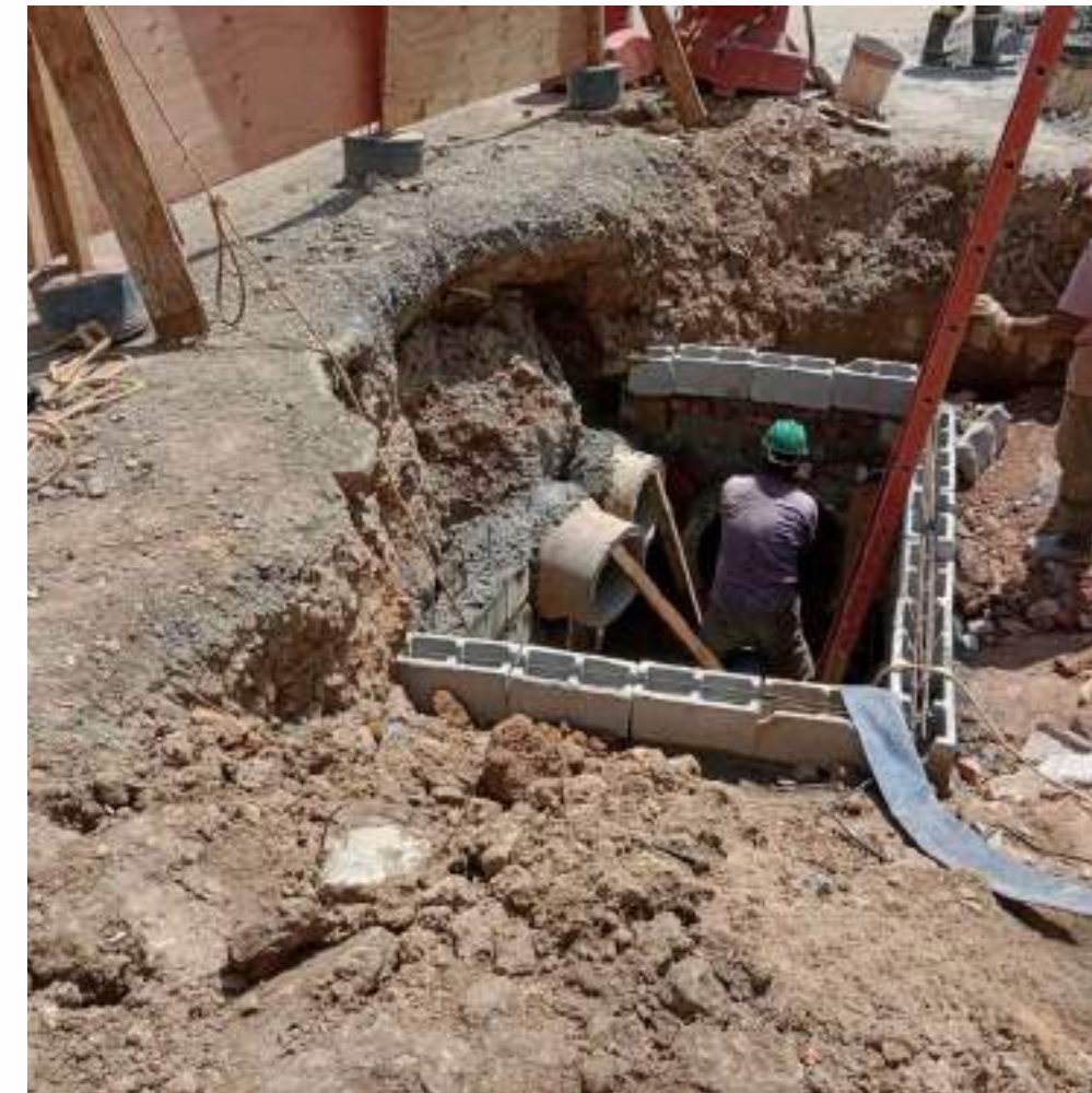
FOTO EM EXECUÇÃO:
