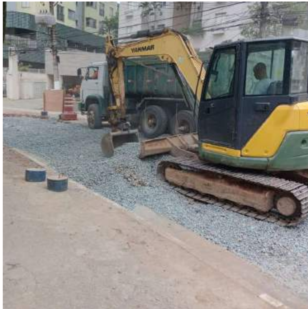
FOTO EM EXECUÇÃO:
