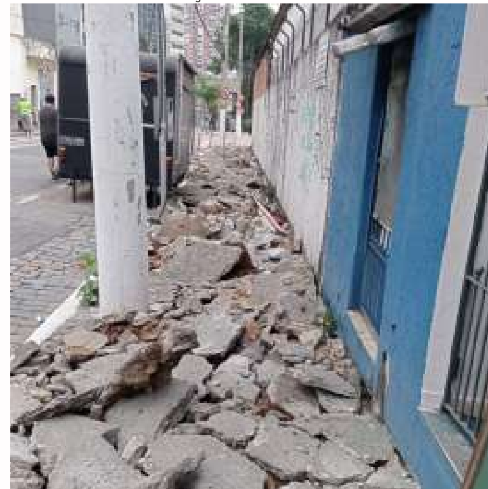
FOTO EM EXECUÇÃO:
