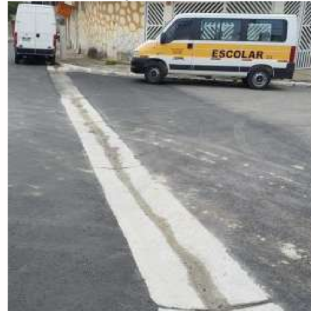
FOTO EM EXECUÇÃO:
