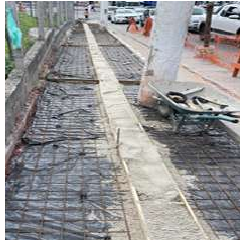
FOTO EM EXECUÇÃO:
