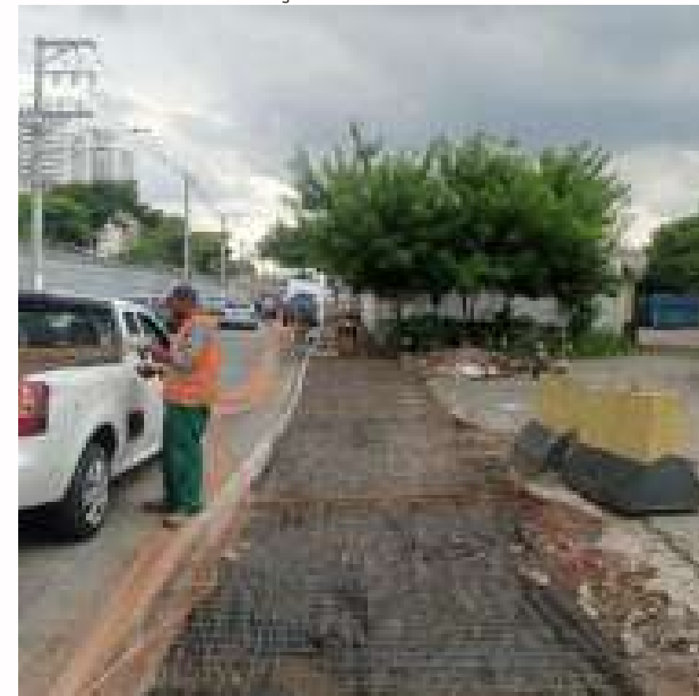
FOTO EM EXECUÇÃO:
