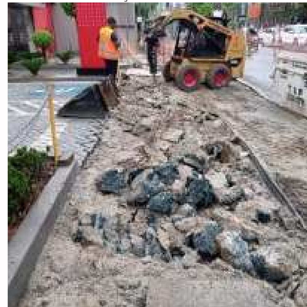
FOTO EM EXECUÇÃO:
