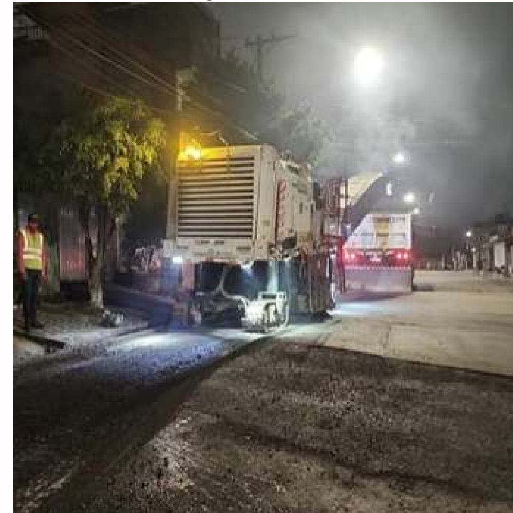
FOTO EM EXECUÇÃO:
