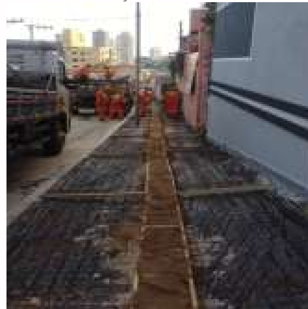
FOTO EM EXECUÇÃO:
