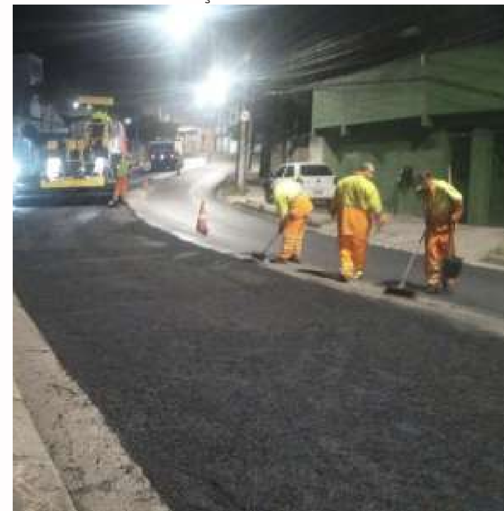
FOTO EM EXECUÇÃO:
