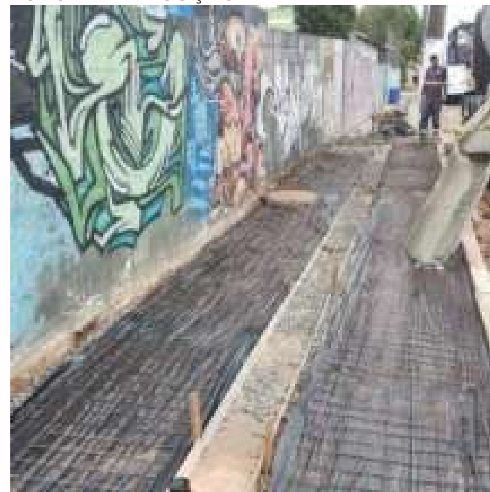
FOTO EM EXECUÇÃO:
