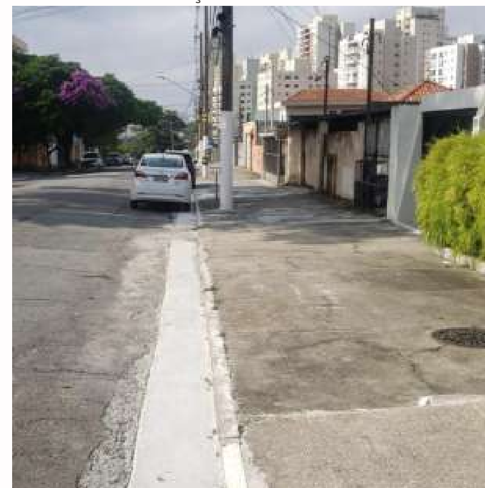
FOTO EM EXECUÇÃO:
