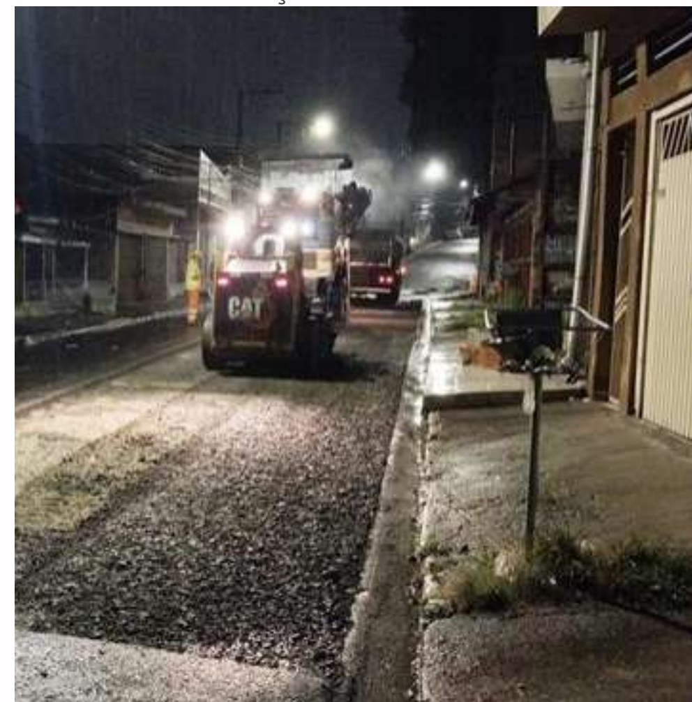
FOTO EM EXECUÇÃO:
