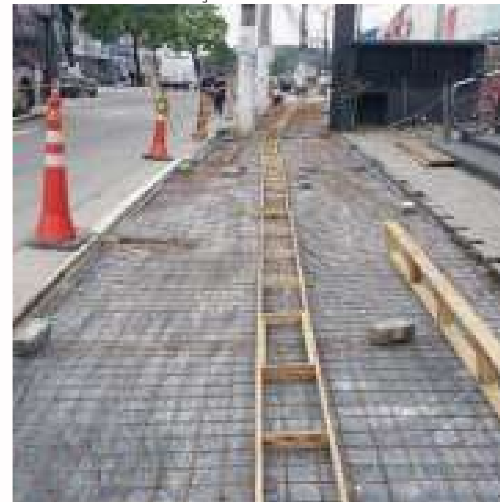
FOTO EM EXECUÇÃO:
