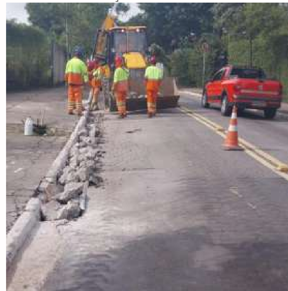
FOTO EM EXECUÇÃO:
