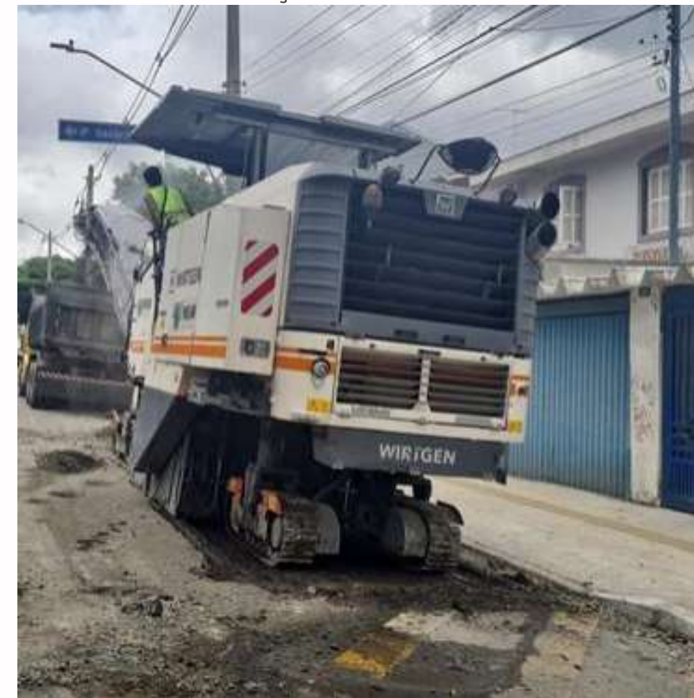
FOTO EM EXECUÇÃO:
