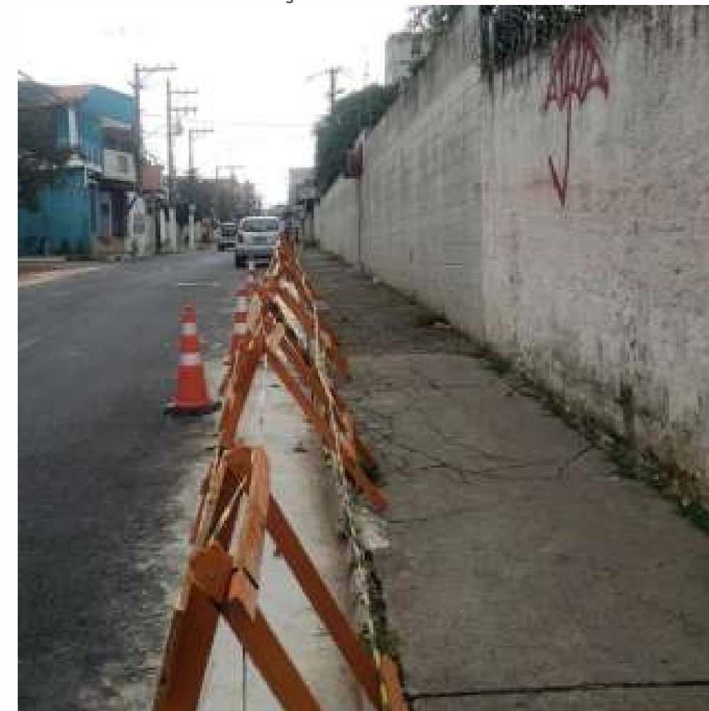
FOTO EM EXECUÇÃO:
