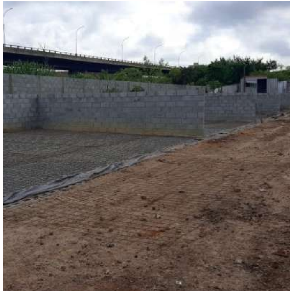
FOTO EM EXECUÇÃO:
