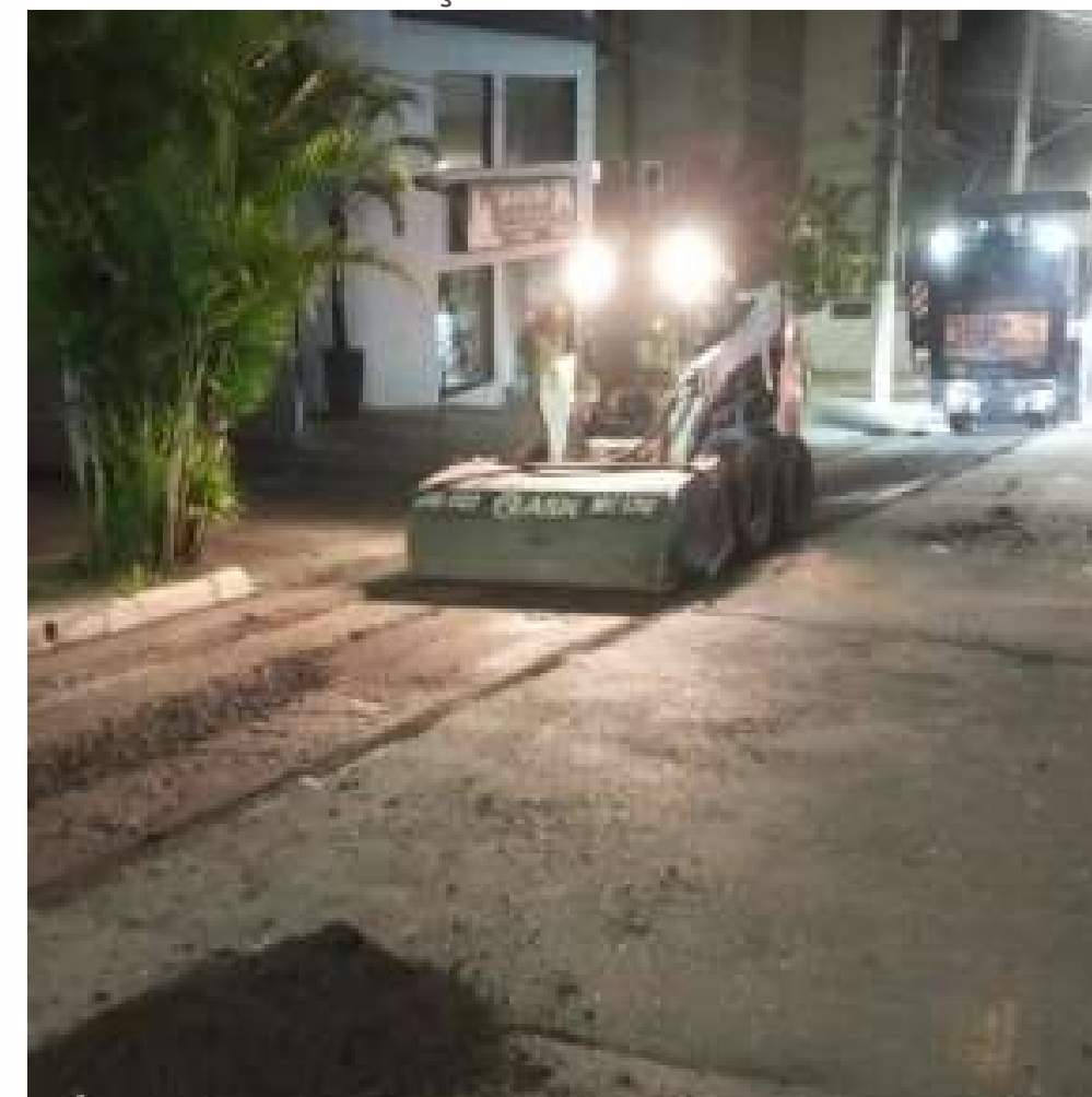
FOTO EM EXECUÇÃO:
