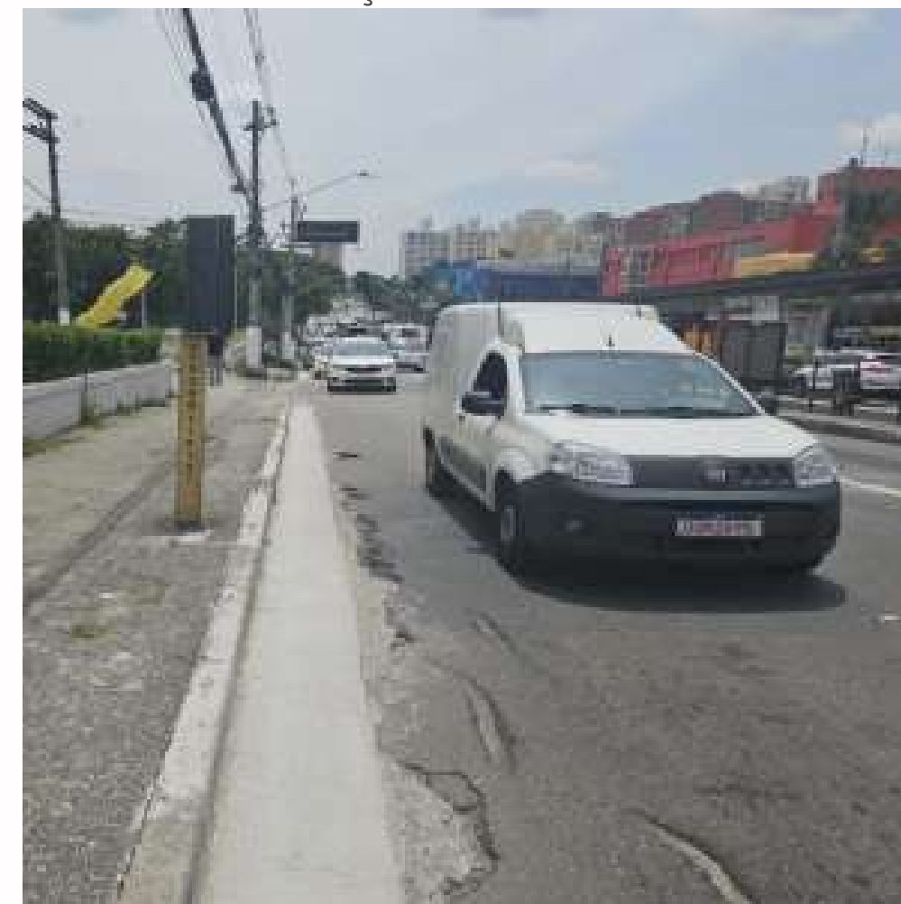
FOTO EM EXECUÇÃO:
