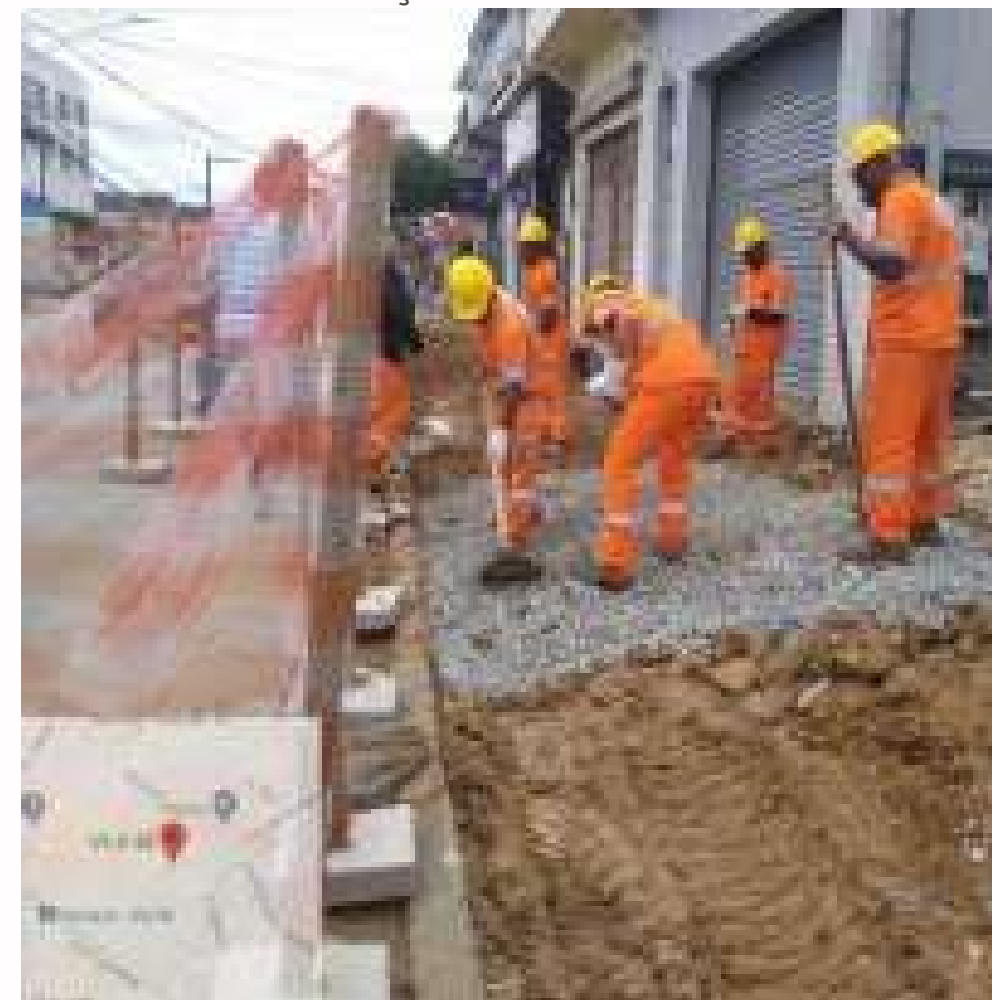
FOTO EM EXECUÇÃO:
