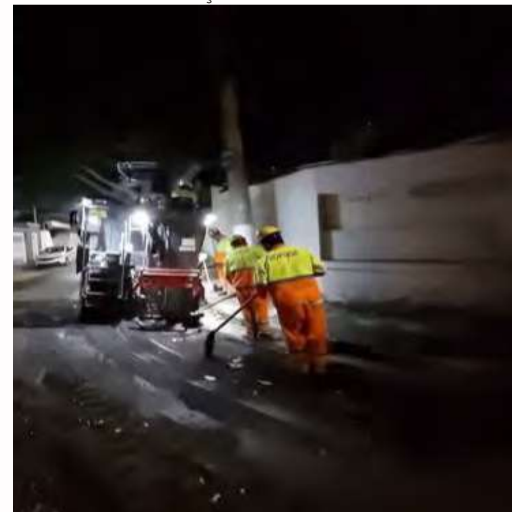
FOTO EM EXECUÇÃO:
