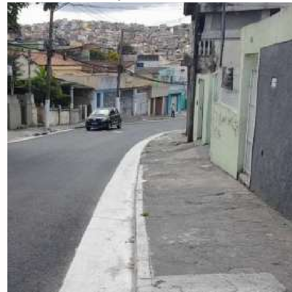
FOTO EM EXECUÇÃO:
