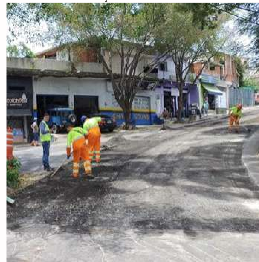
FOTO EM EXECUÇÃO:
