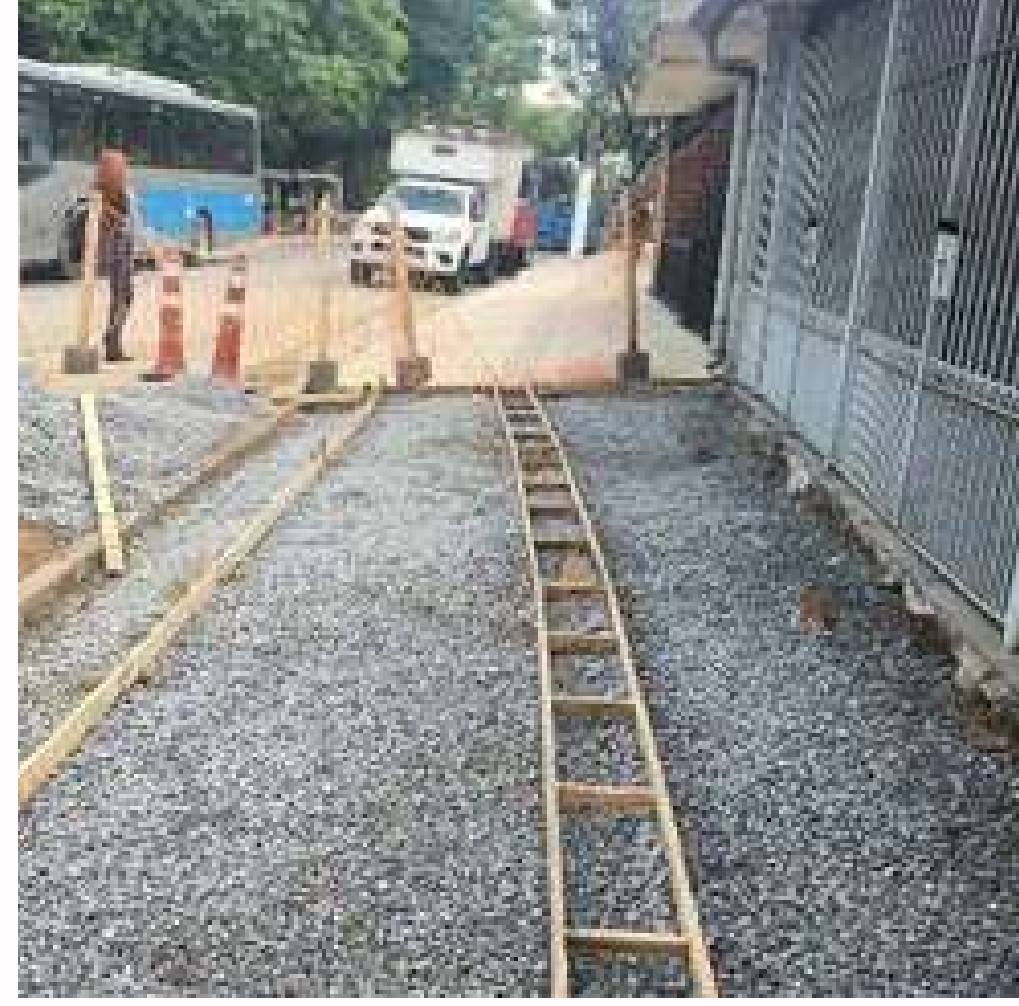
FOTO EM EXECUÇÃO:
