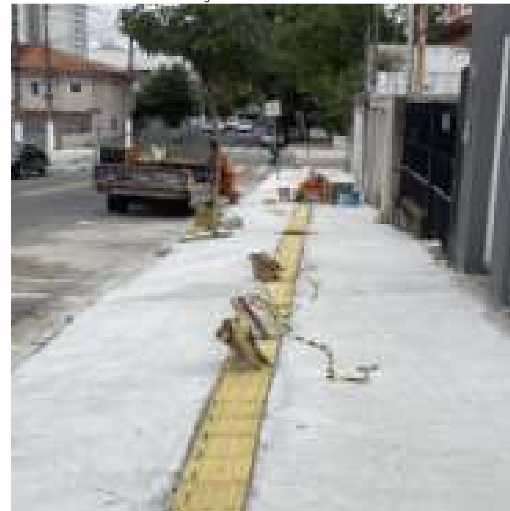
FOTO EM EXECUÇÃO:
