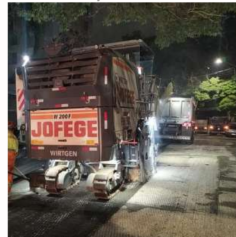
FOTO EM EXECUÇÃO:
