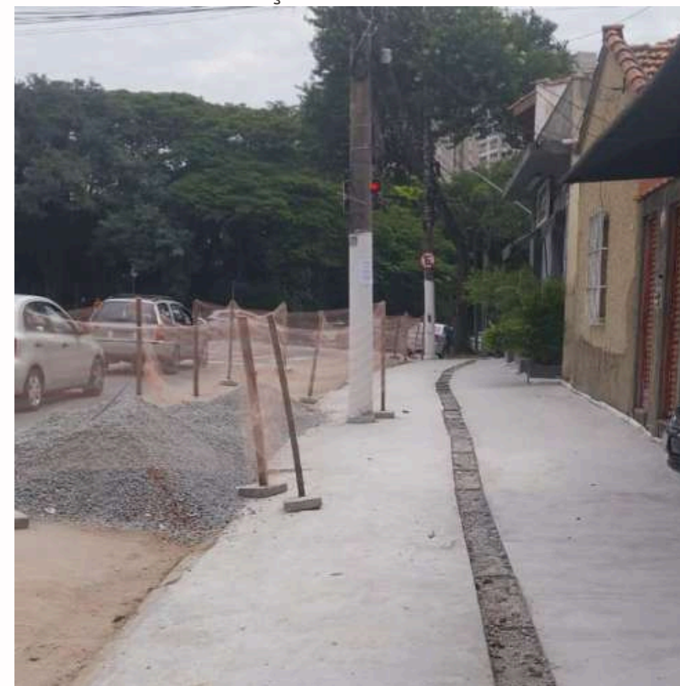
FOTO EM EXECUÇÃO:
