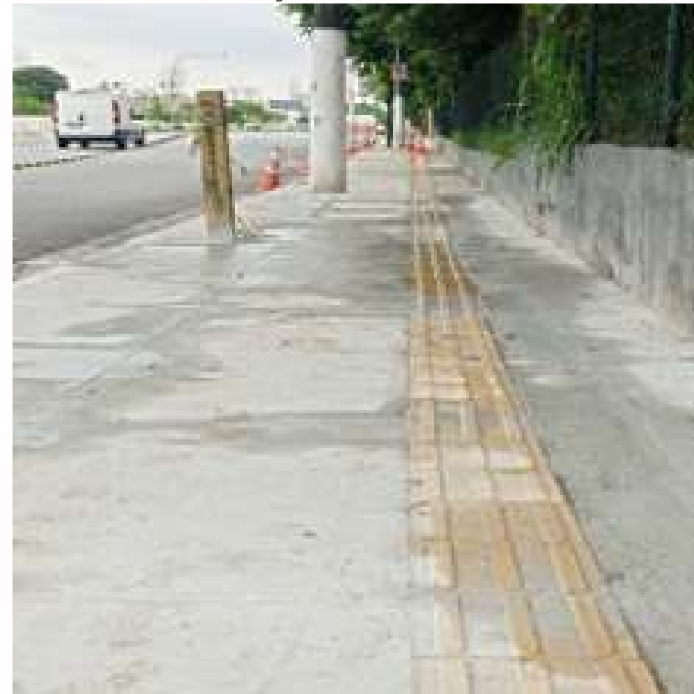
FOTO EM EXECUÇÃO:
