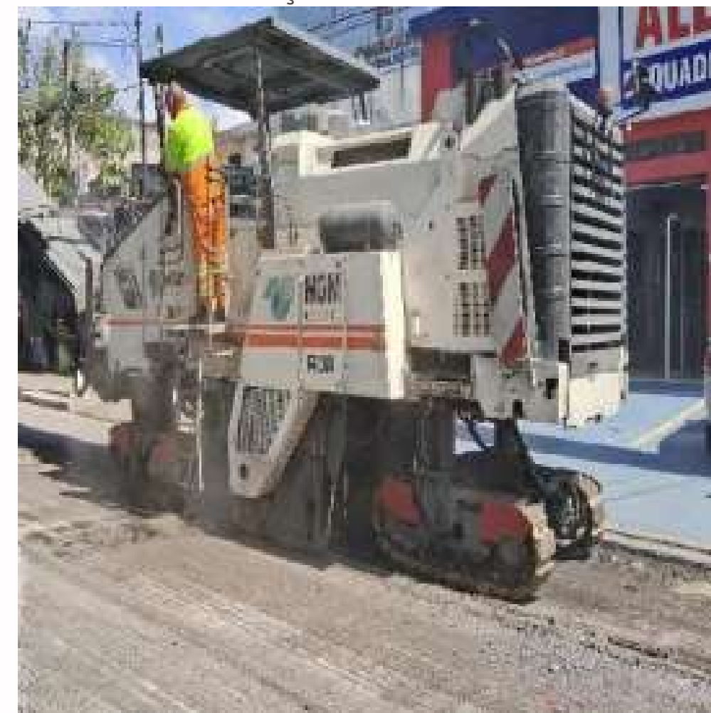
FOTO EM EXECUÇÃO:
