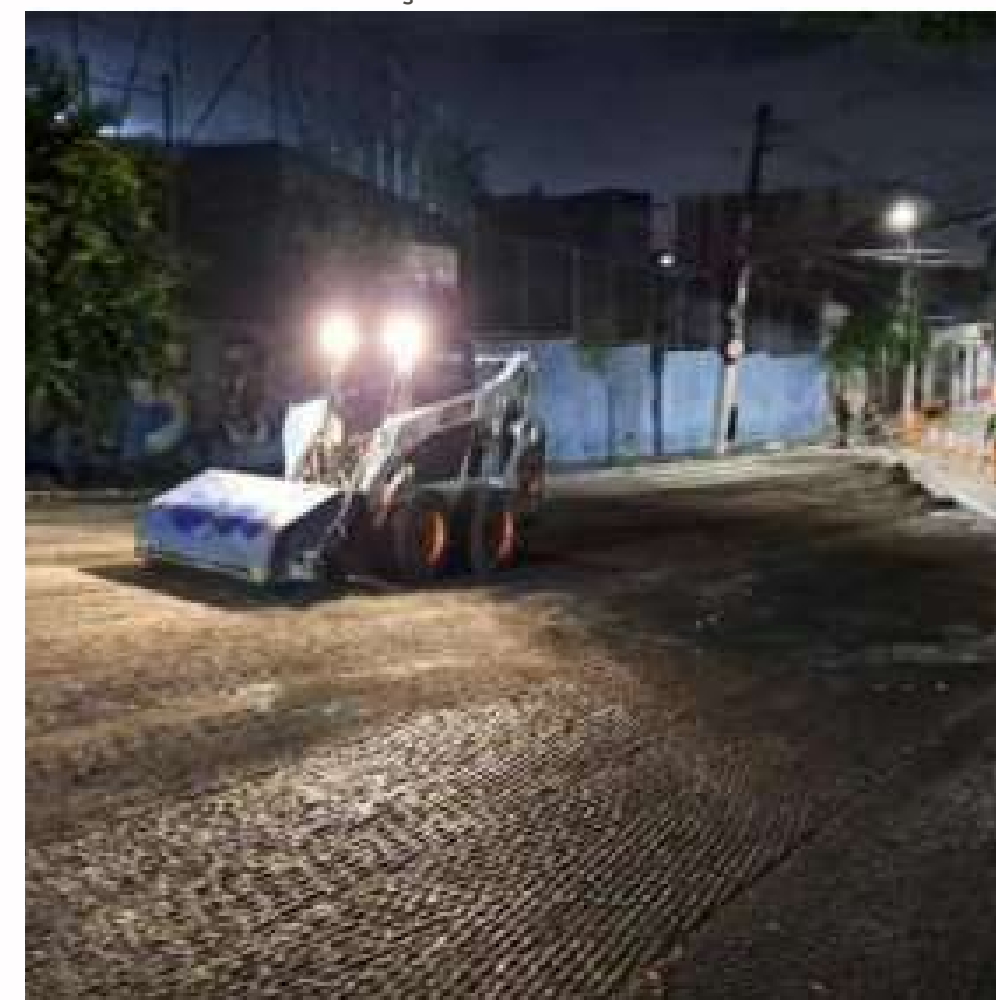
FOTO EM EXECUÇÃO:
