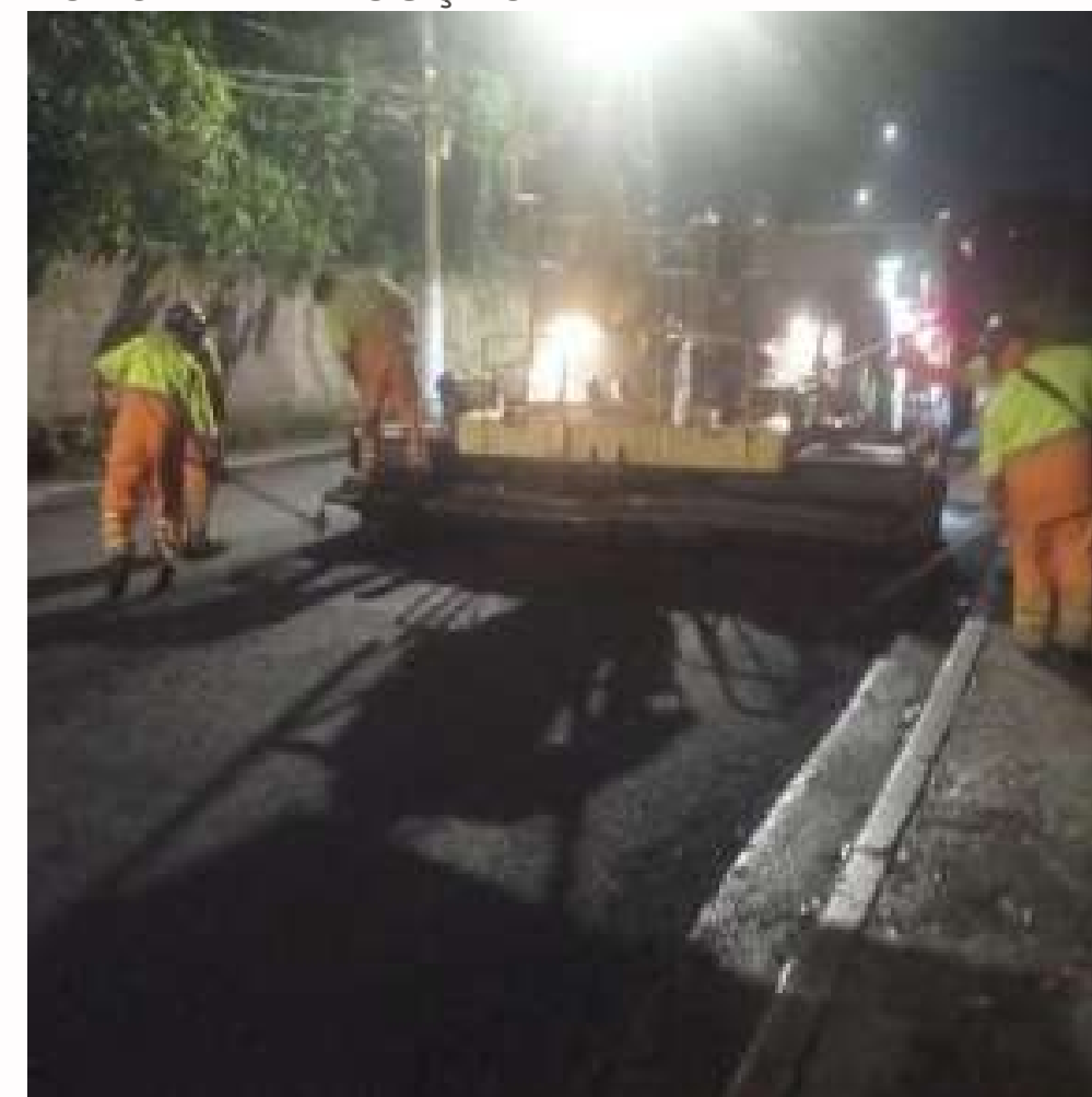
FOTO EM EXECUÇÃO:
