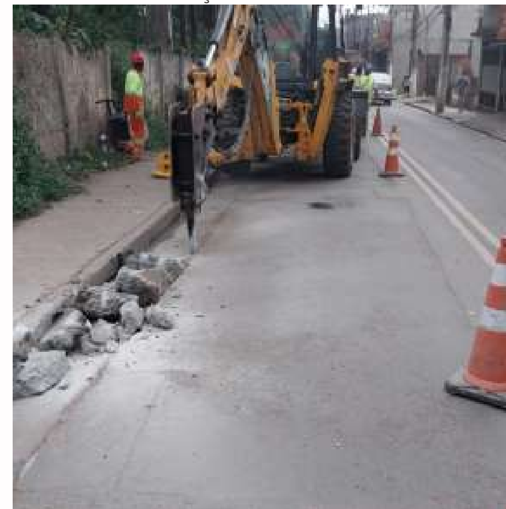
FOTO EM EXECUÇÃO:
