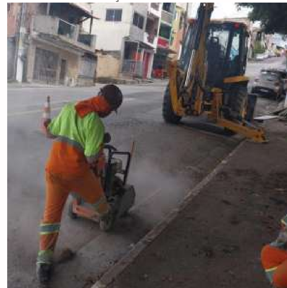
FOTO EM EXECUÇÃO:
