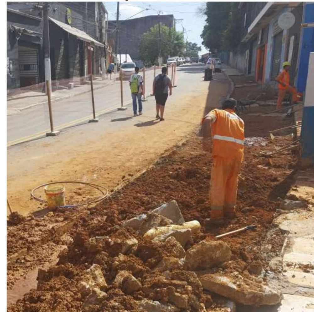
FOTO EM EXECUÇÃO:
