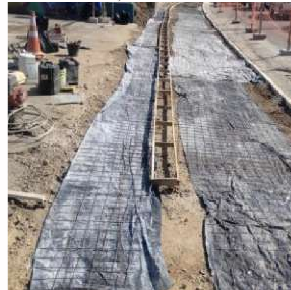
FOTO EM EXECUÇÃO:
