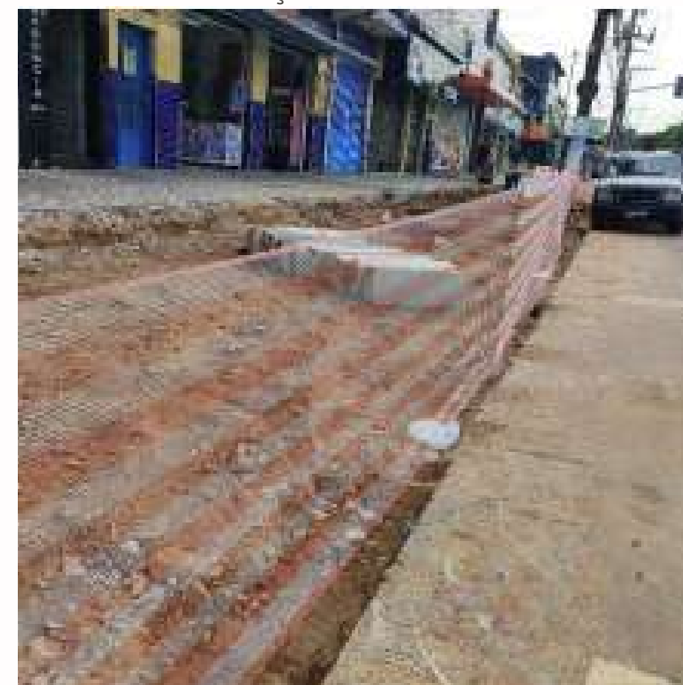
FOTO EM EXECUÇÃO:
