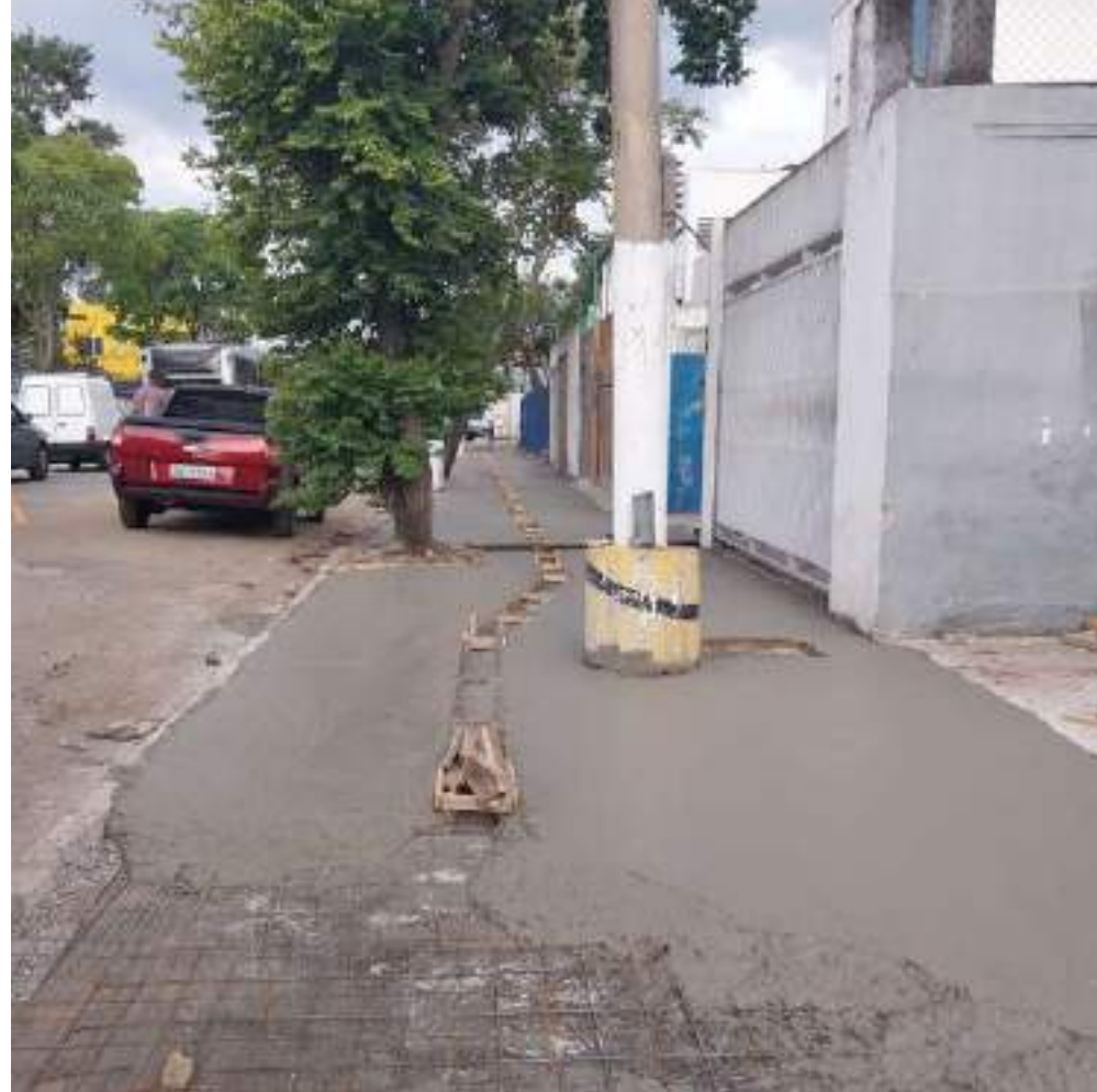
FOTO EM EXECUÇÃO:
