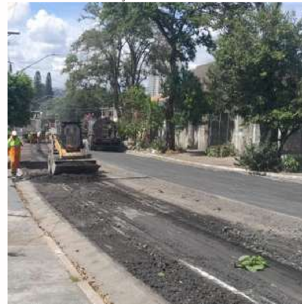
FOTO EM EXECUÇÃO:
