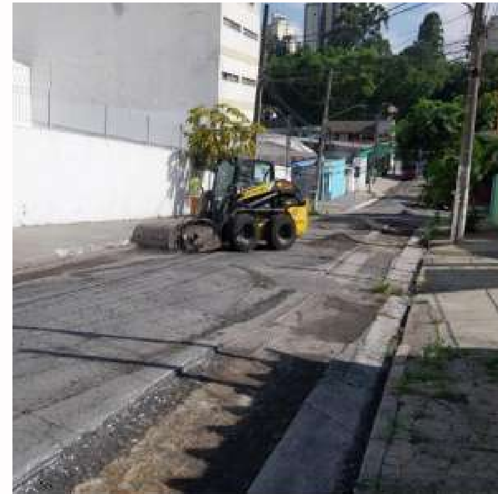
FOTO EM EXECUÇÃO:
