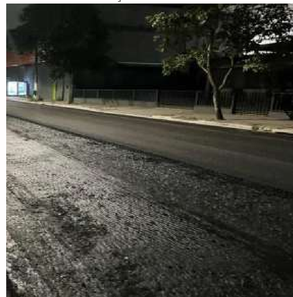
FOTO EM EXECUÇÃO:
