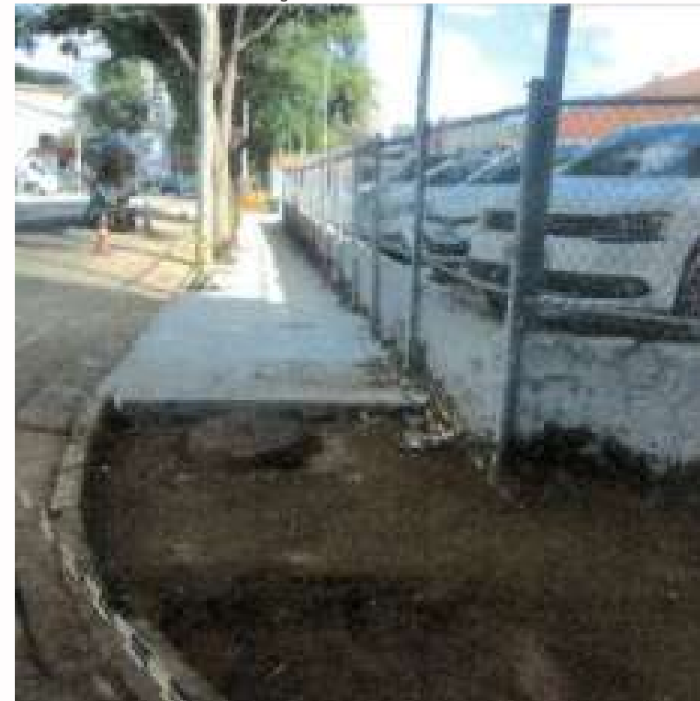
FOTO EM EXECUÇÃO:
