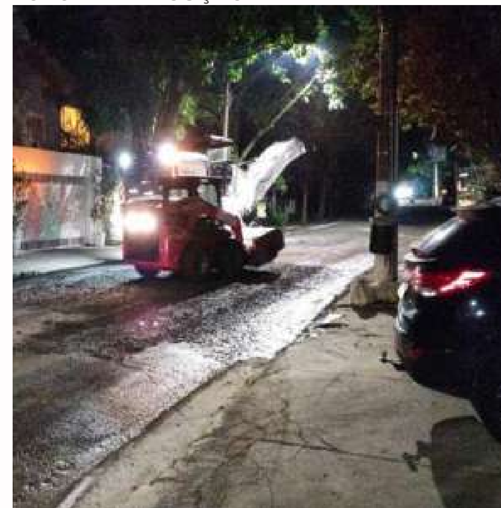
FOTO EM EXECUÇÃO:
