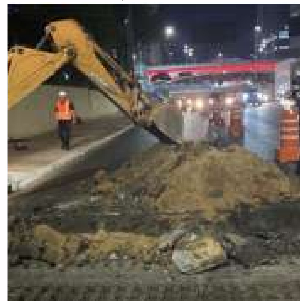
FOTO EM EXECUÇÃO:
