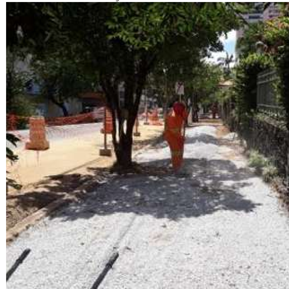
FOTO EM EXECUÇÃO:
