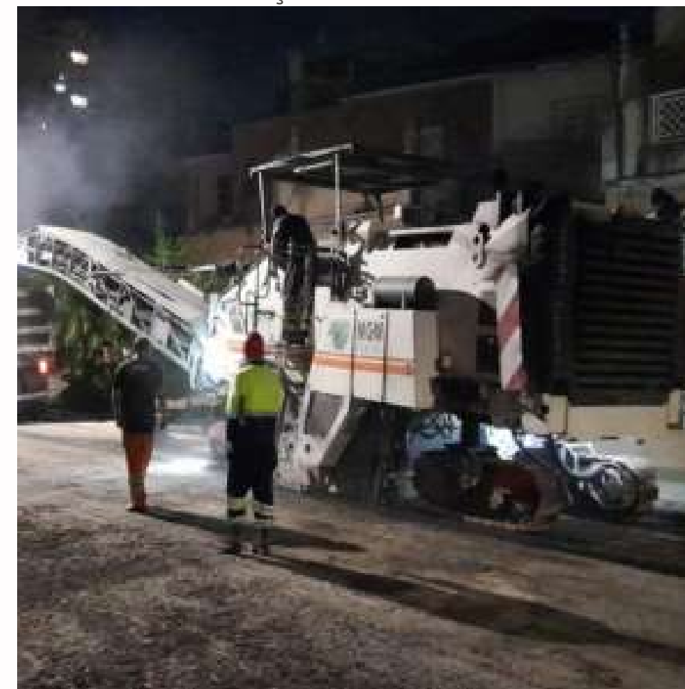
FOTO EM EXECUÇÃO:
