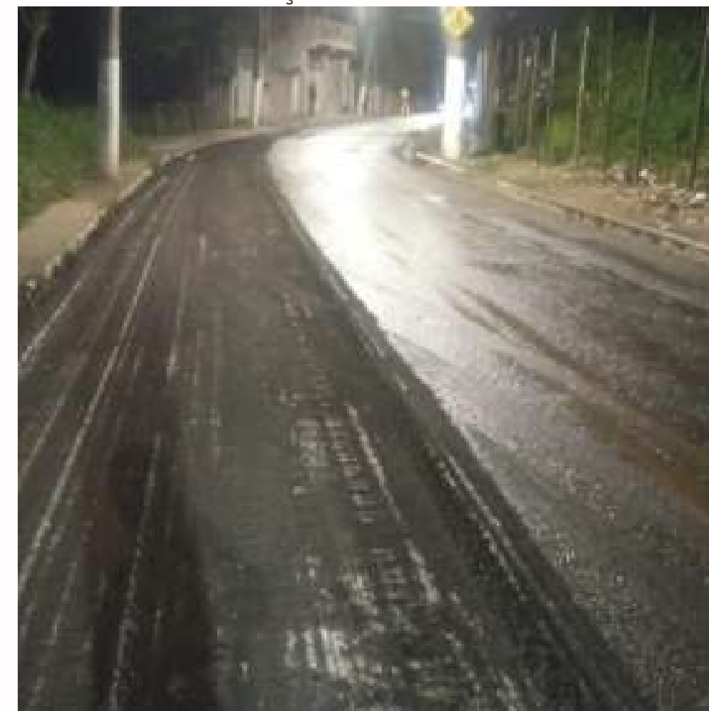
FOTO EM EXECUÇÃO:
