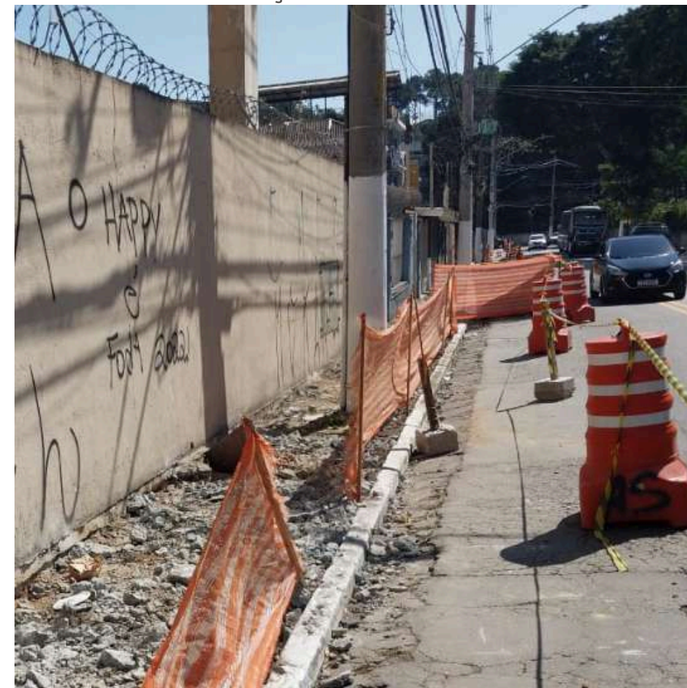
FOTO EM EXECUÇÃO:
