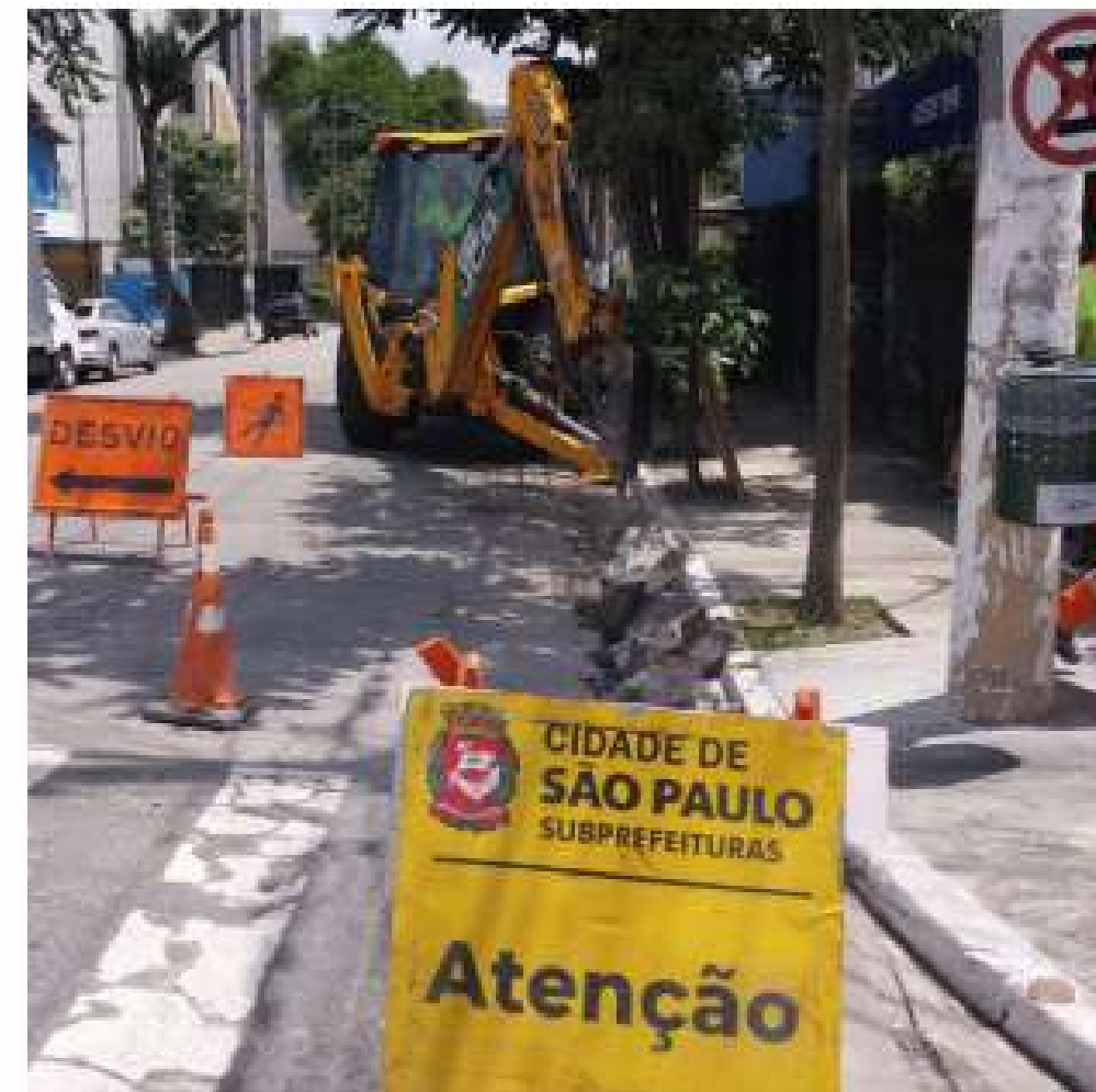
FOTO EM EXECUÇÃO:
