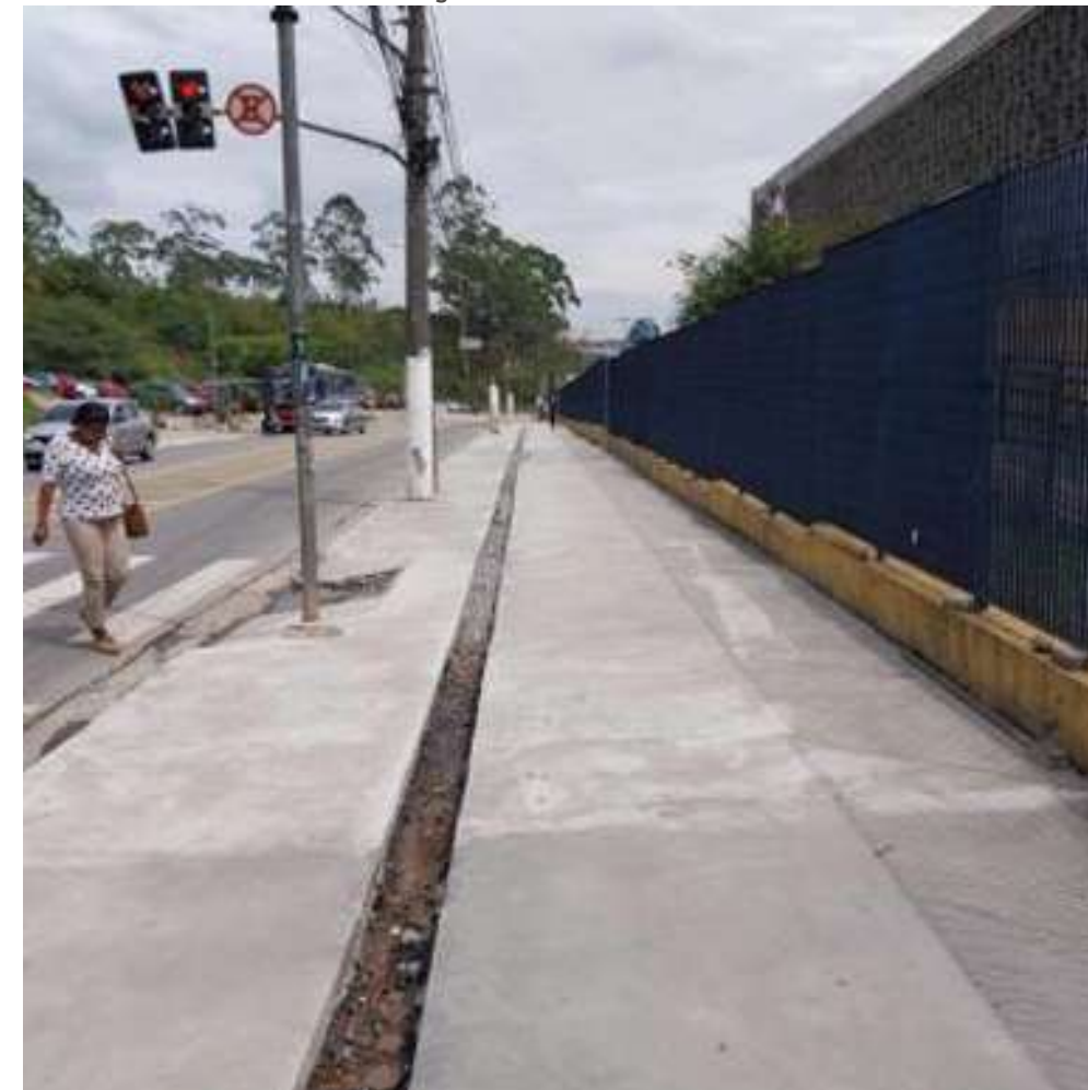
FOTO EM EXECUÇÃO:
