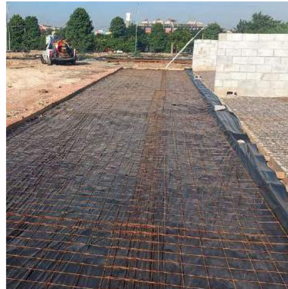
FOTO EM EXECUÇÃO:
