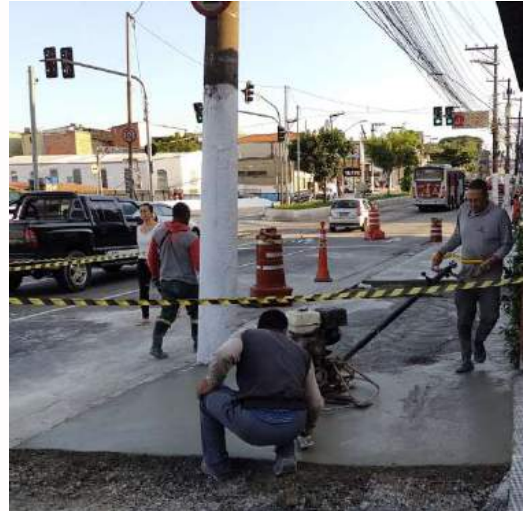
FOTO EM EXECUÇÃO:
