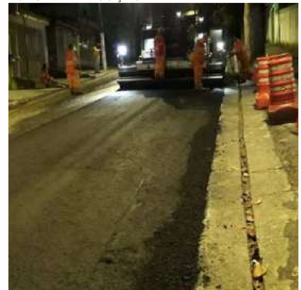
FOTO EM EXECUÇÃO:
