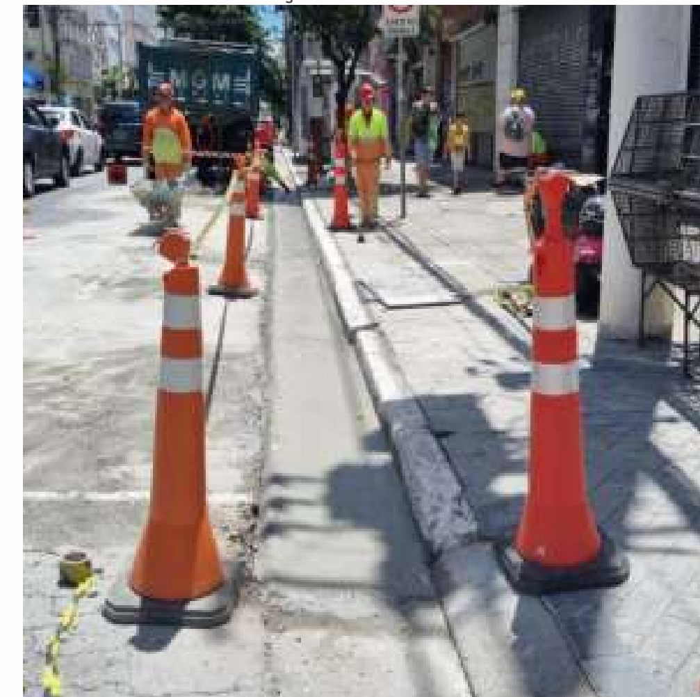
FOTO EM EXECUÇÃO:
