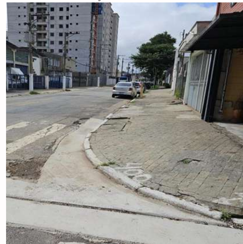
FOTO EM EXECUÇÃO:
