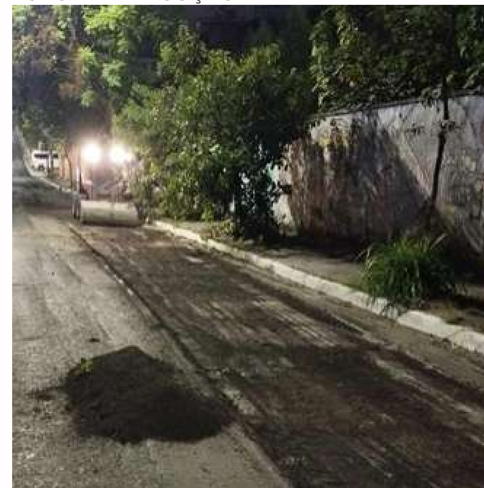
FOTO EM EXECUÇÃO:
