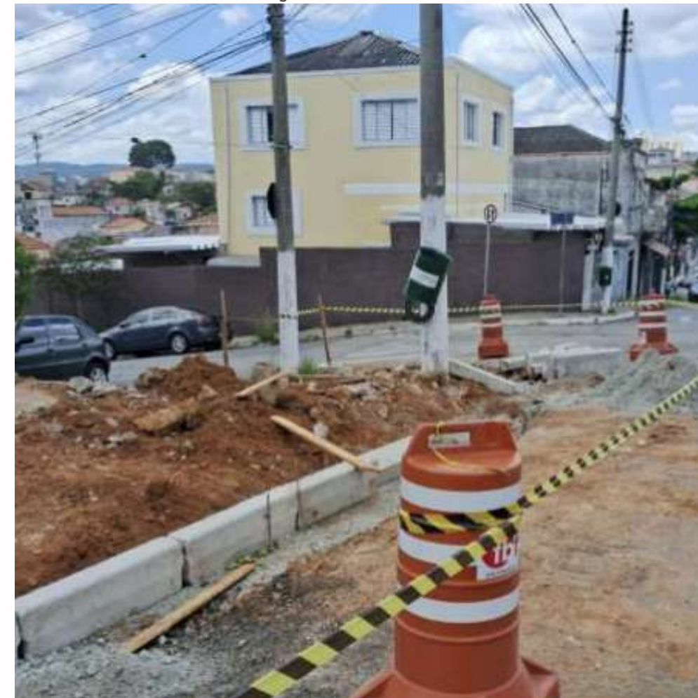
FOTO EM EXECUÇÃO:
