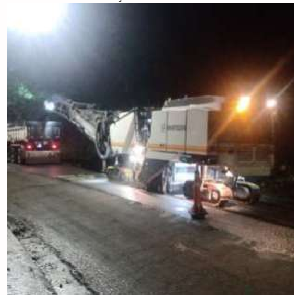
FOTO EM EXECUÇÃO:
