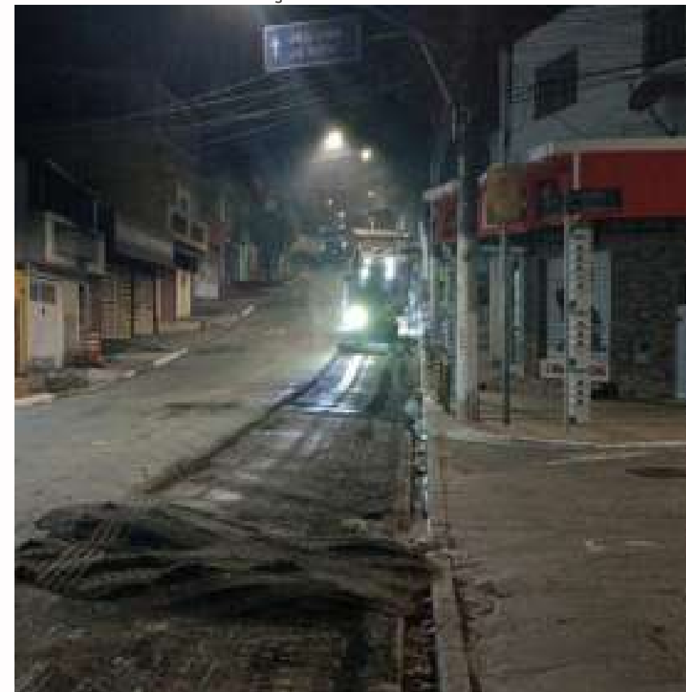
FOTO EM EXECUÇÃO:
