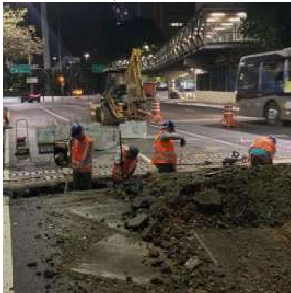
FOTO EM EXECUÇÃO:
