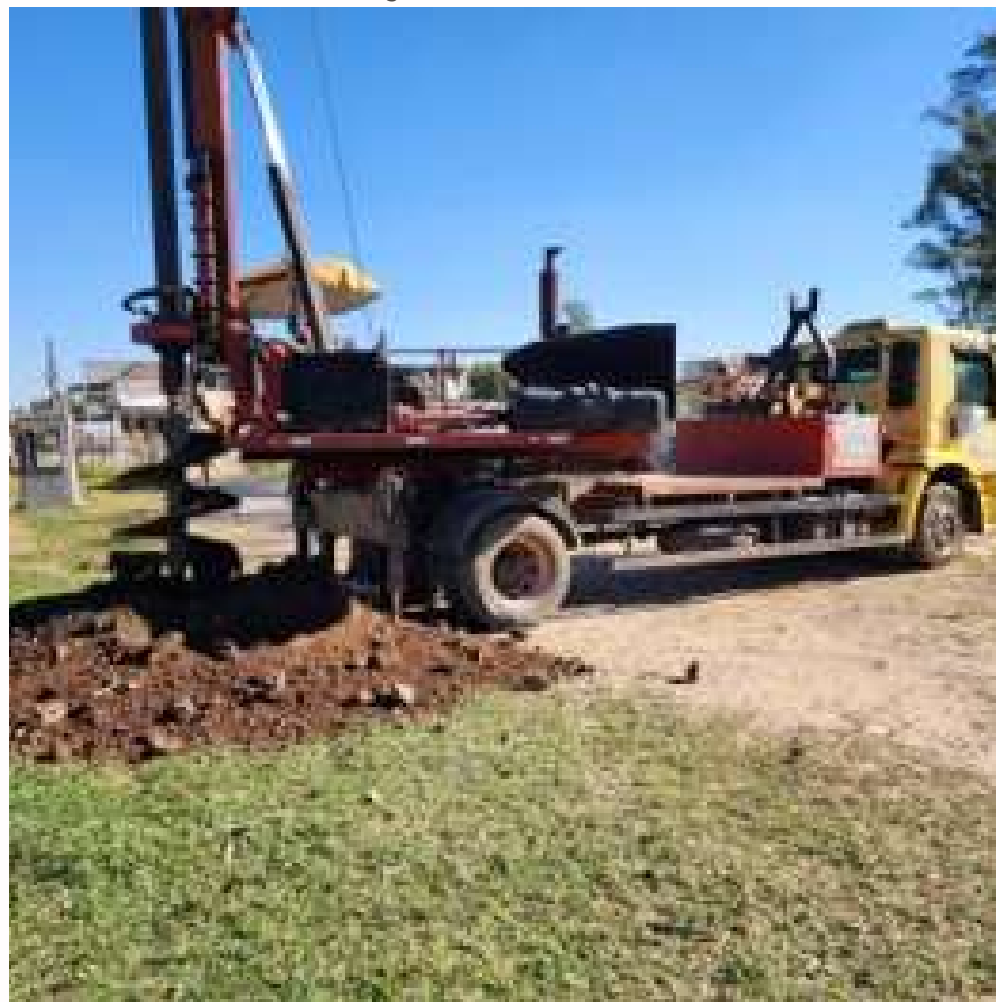
FOTO EM EXECUÇÃO:
