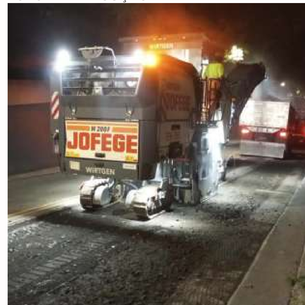
FOTO EM EXECUÇÃO:
