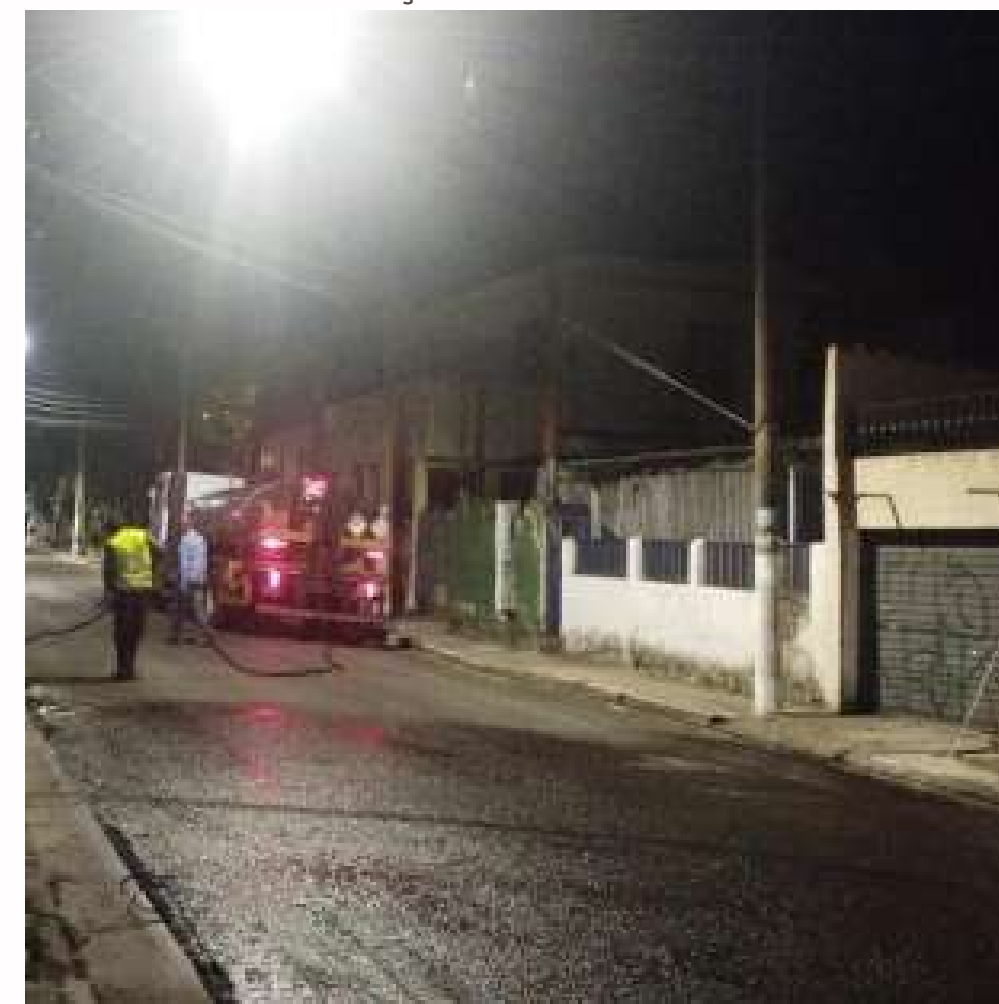
FOTO EM EXECUÇÃO:
