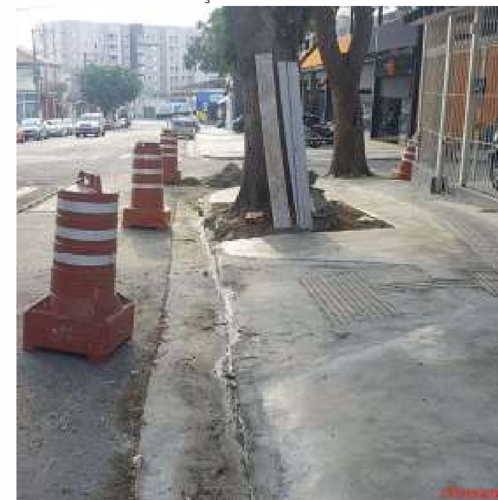
FOTO EM EXECUÇÃO:
