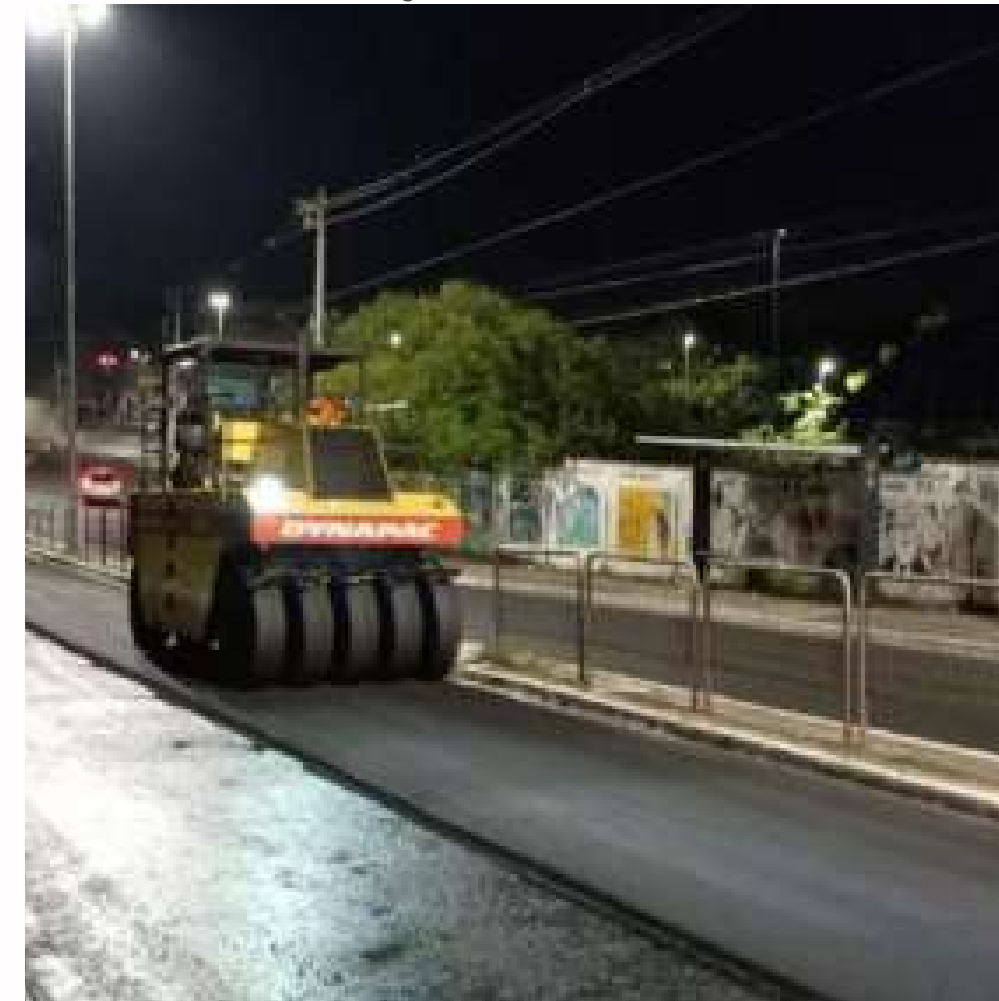
FOTO EM EXECUÇÃO:
