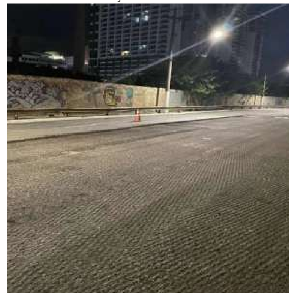
FOTO EM EXECUÇÃO:
