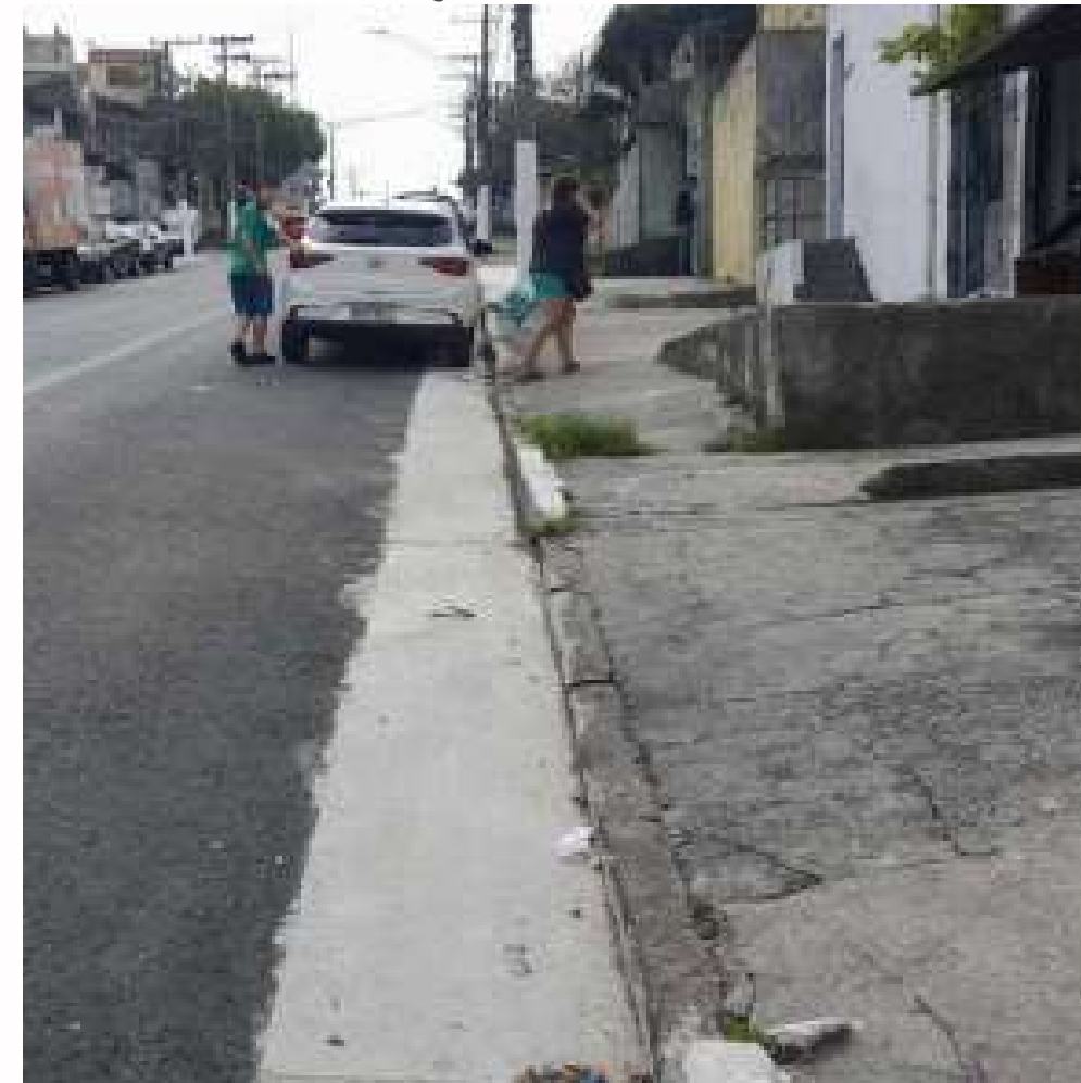
FOTO EM EXECUÇÃO:
