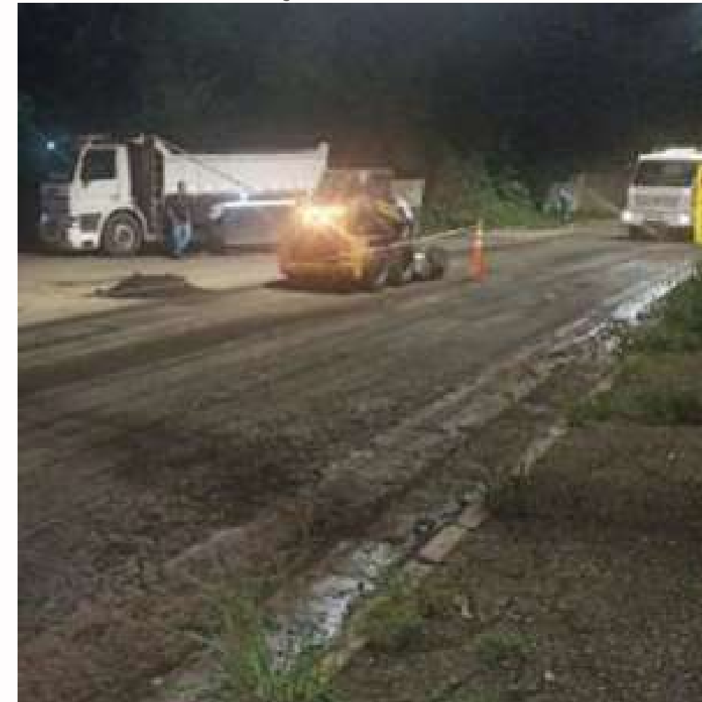
FOTO EM EXECUÇÃO:
