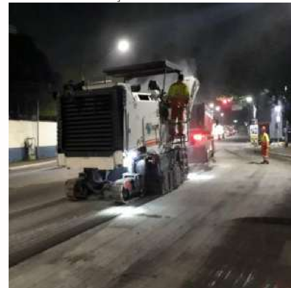
FOTO EM EXECUÇÃO:
