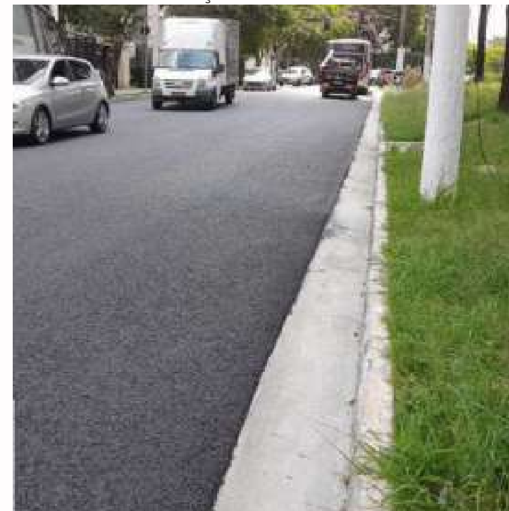
FOTO EM EXECUÇÃO:
