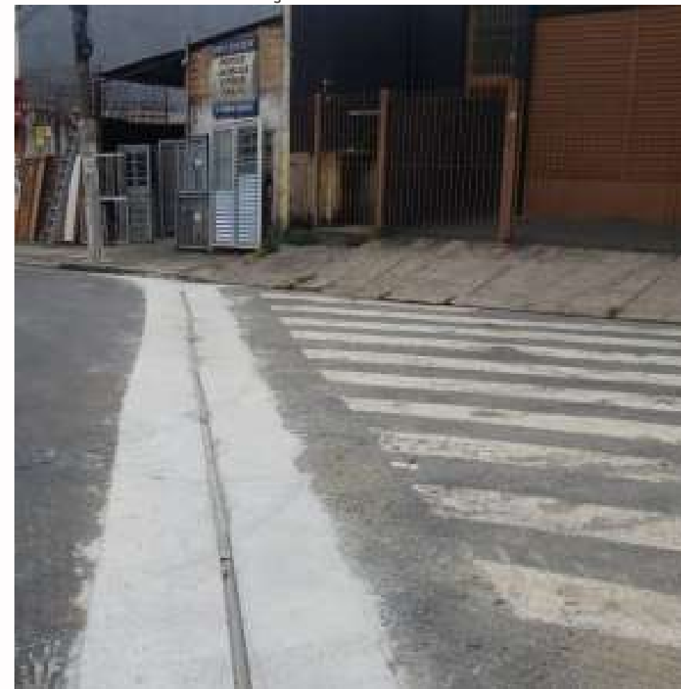
FOTO EM EXECUÇÃO:
