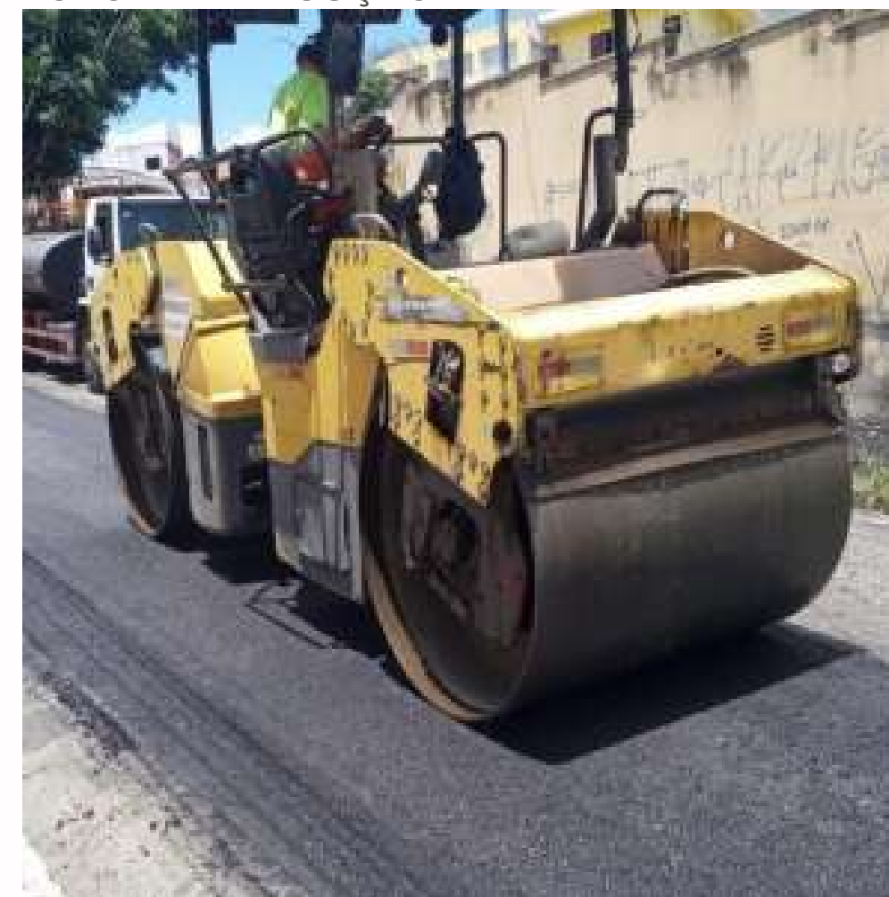
FOTO EM EXECUÇÃO:
