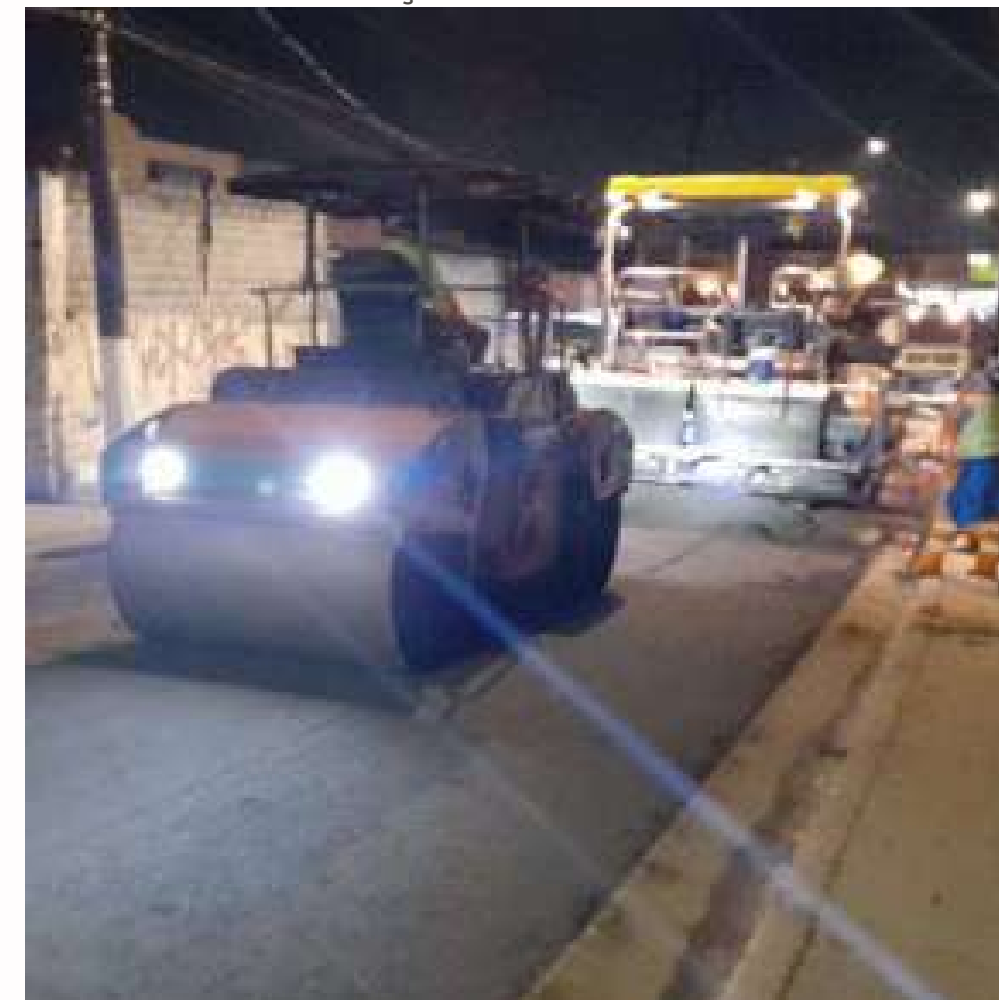
FOTO EM EXECUÇÃO:
