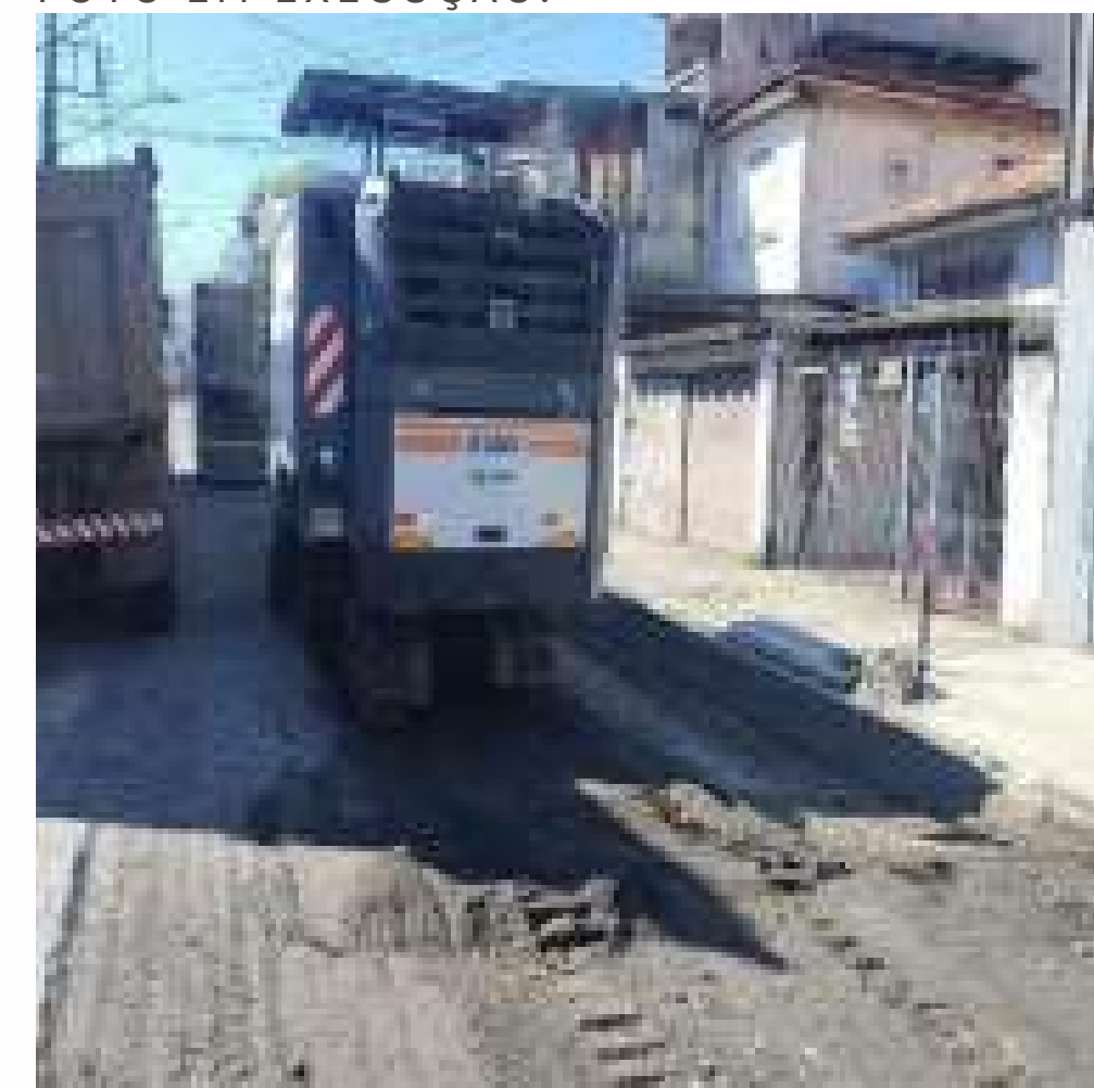
FOTO EM EXECUÇÃO:
