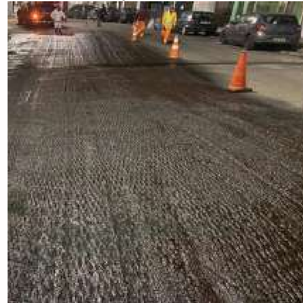
FOTO EM EXECUÇÃO:
