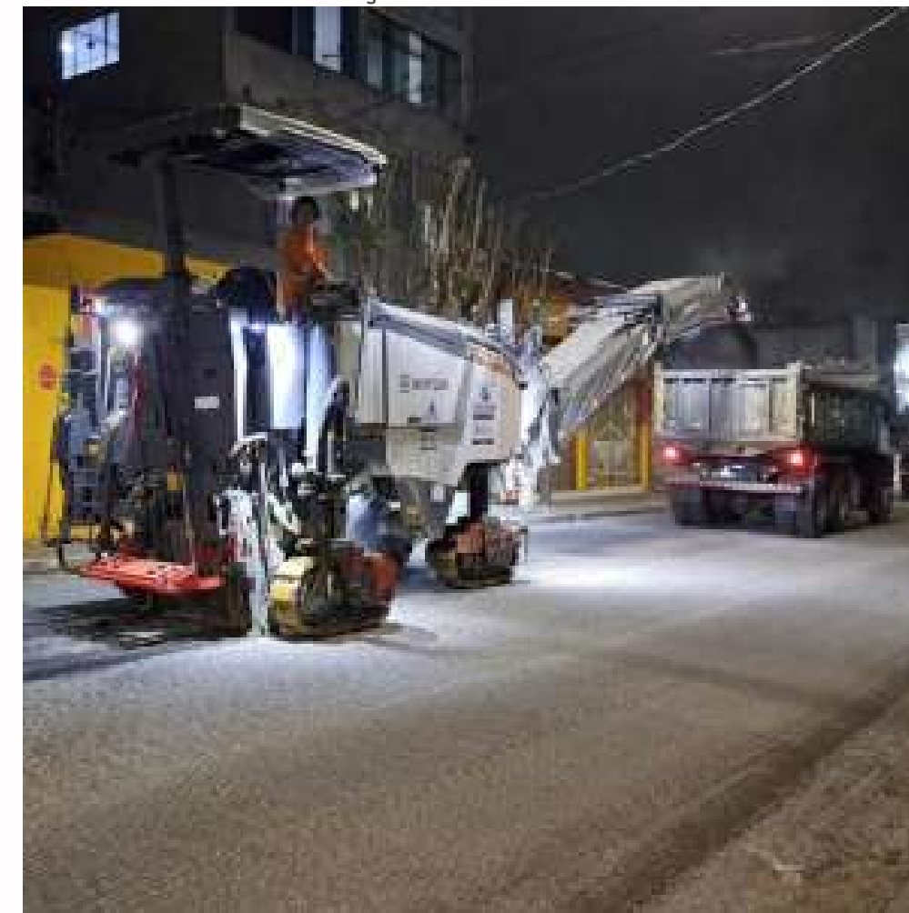
FOTO EM EXECUÇÃO:
