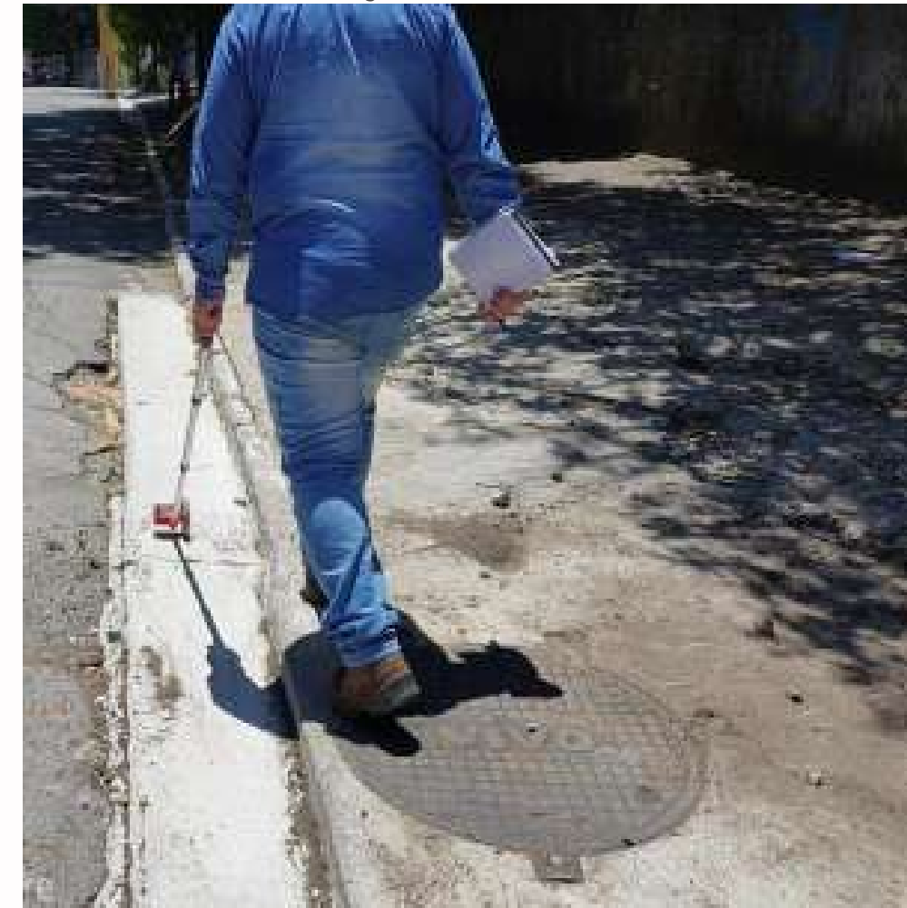
FOTO EM EXECUÇÃO:
