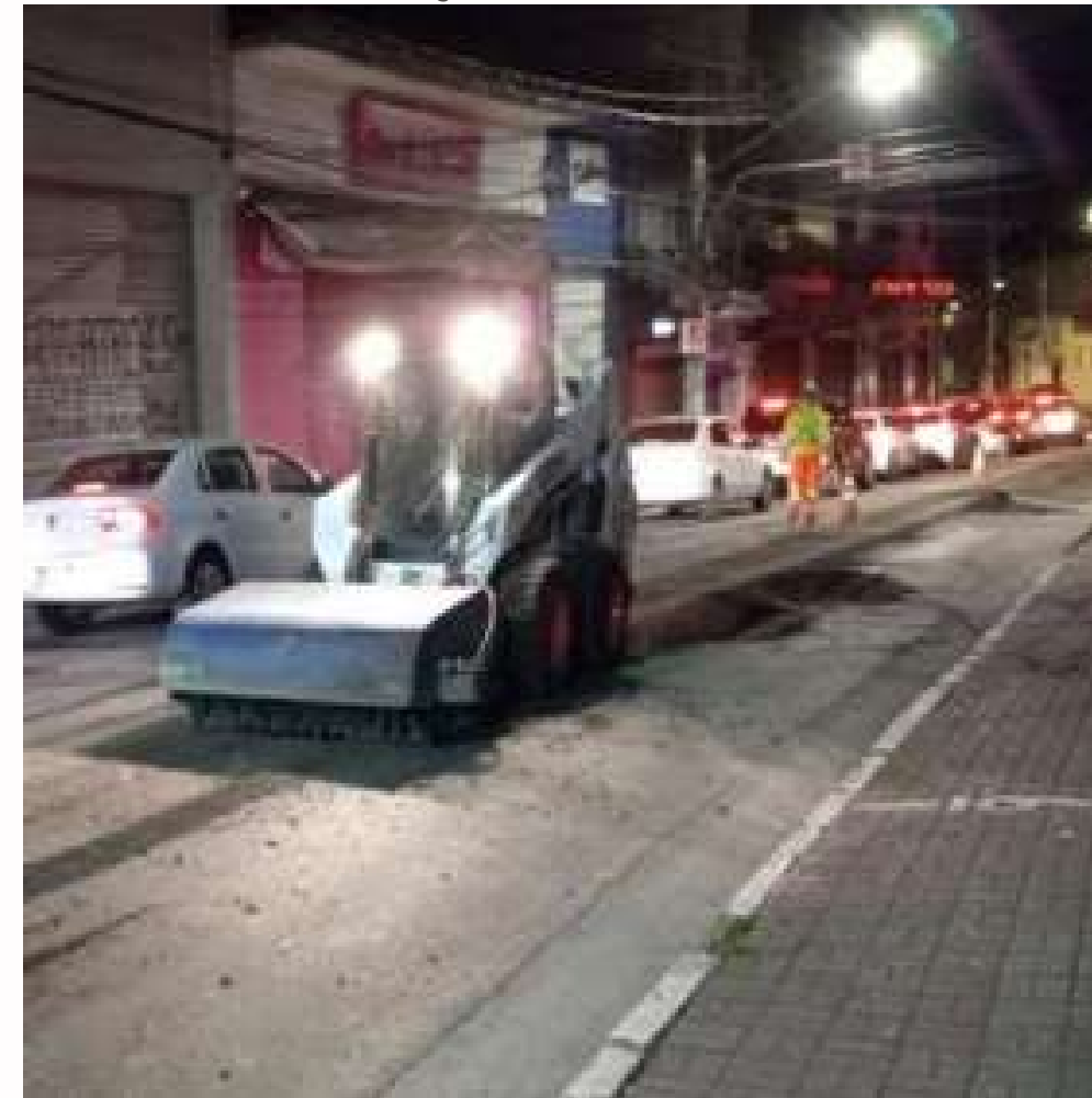
FOTO EM EXECUÇÃO:
