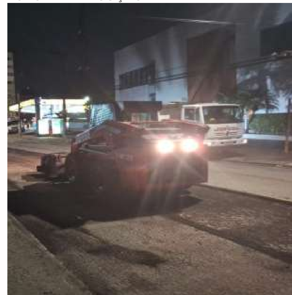
FOTO EM EXECUÇÃO:
