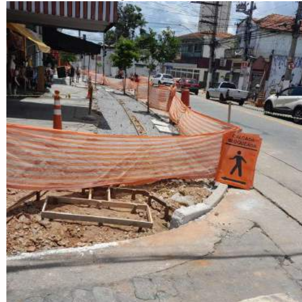
FOTO EM EXECUÇÃO:
